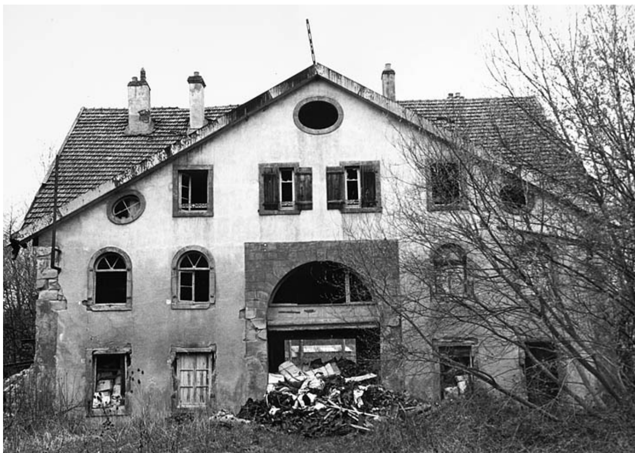
Bâtiment d'entrée ouest en 1977. Façade postérieure.
