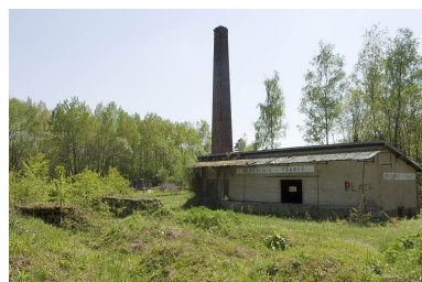
Emplacement de l'ancienne saline. Phot. Jérôme Mongreville IVR43_20067000258NUCA
