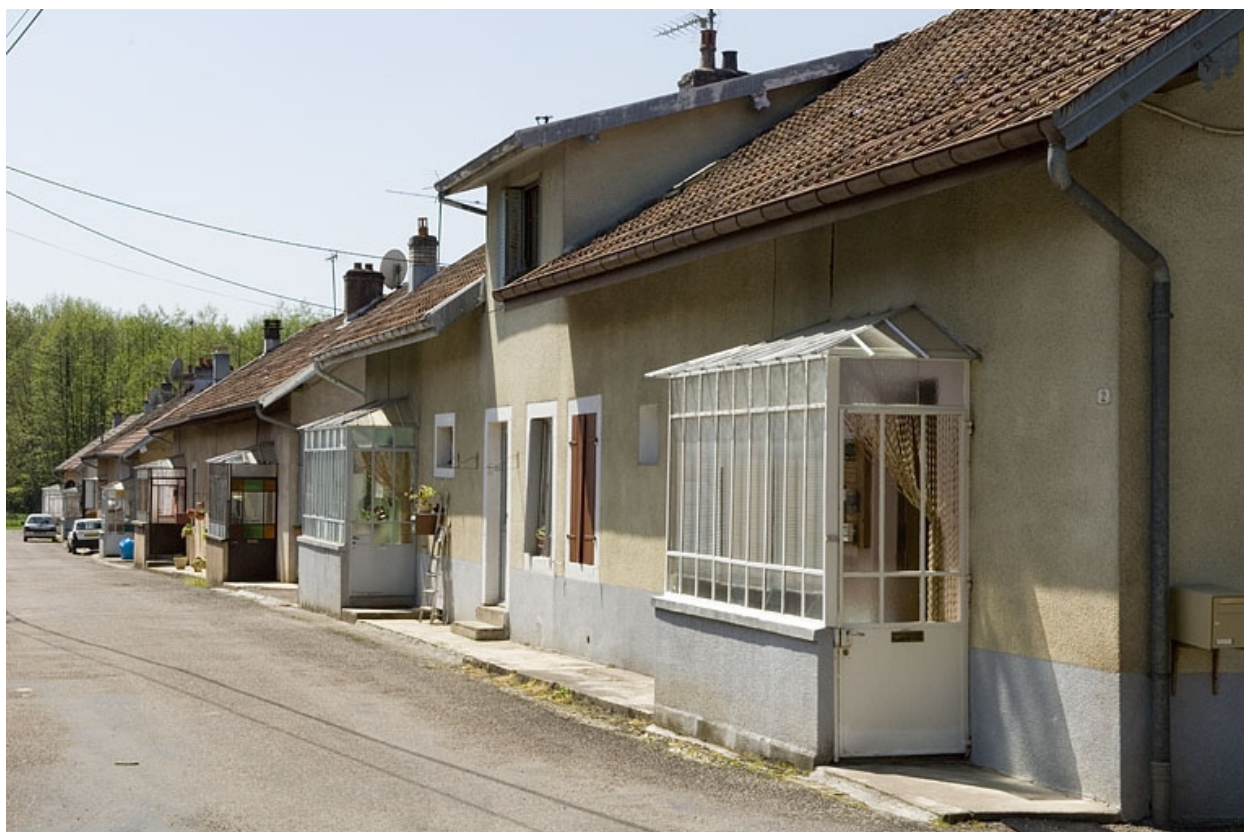
Alignement de façades de la cité ouvrière.
