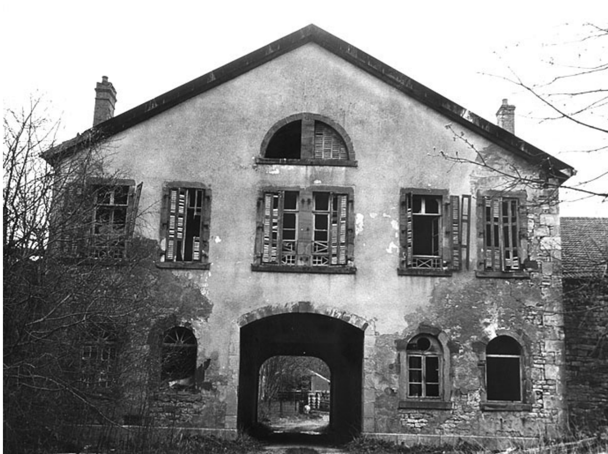
Bureau de la Régie en 1977. Façade antérieure.
