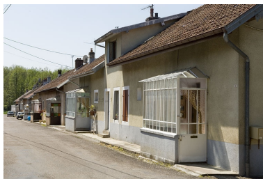
Alignement de façades de la cité ouvrière. Phot. Jérôme Mongreville IVR43_20067000260NUCA
