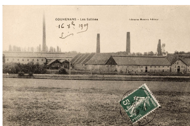
Gouhenans - Les Salines. Phot. Jérôme Mongreville IVR43_20057000592NUCA
