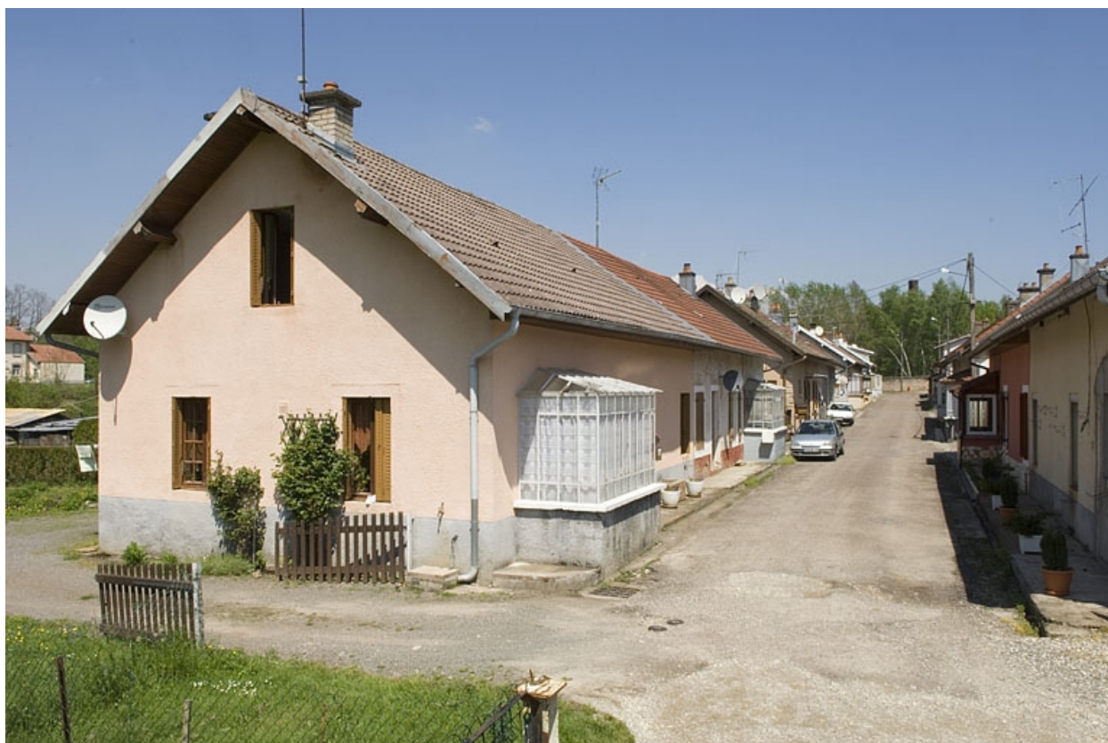
Vue d'ensemble de la cité ouvrière.
