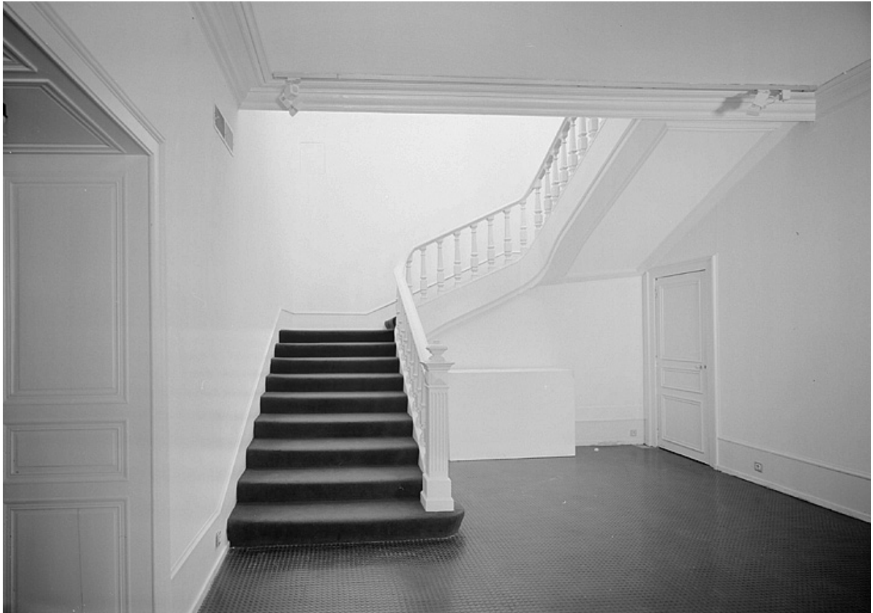
Escalier du corps de bâtiment principal.
