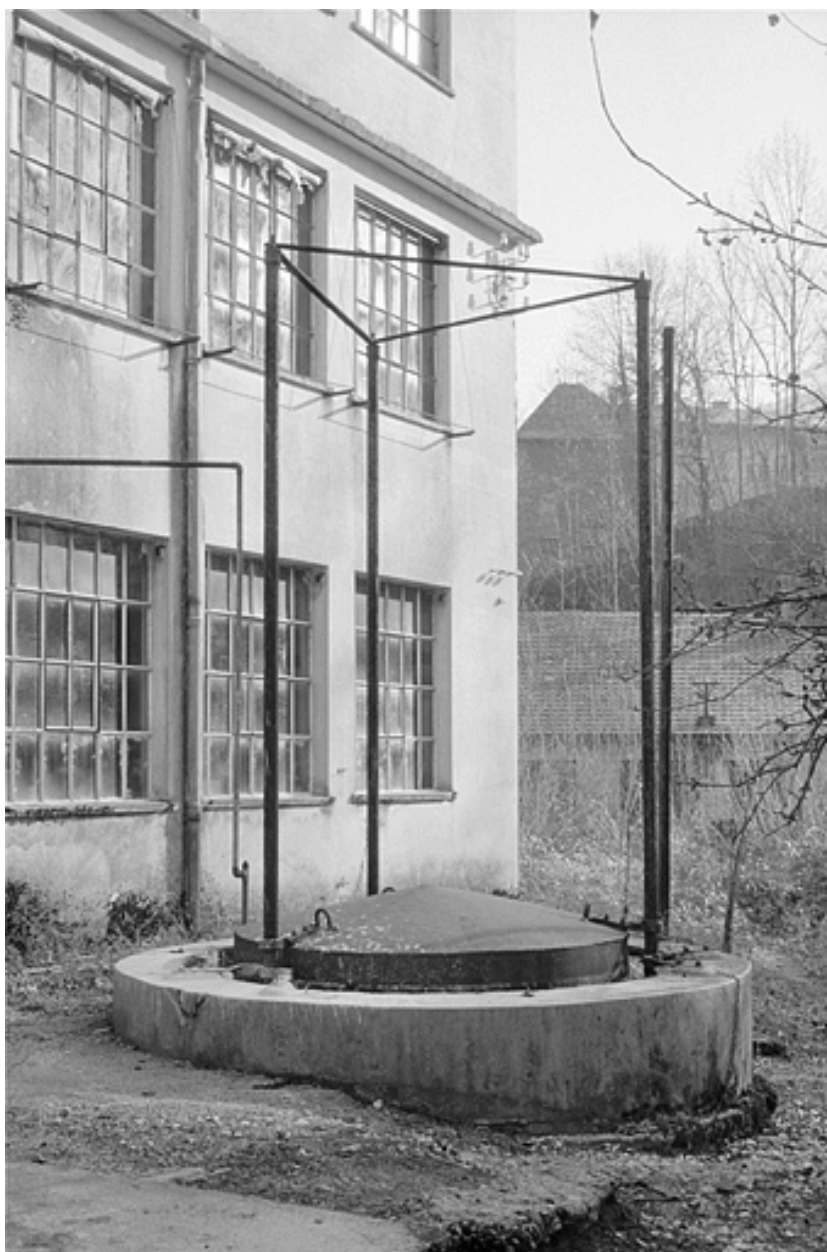
Gazomètre (stockage d'acétylène).
