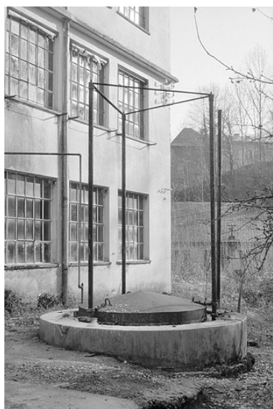
Gazomètre (stockage d'acétylène). Phot. Laurent Poupard IVR43_19913901134Z
