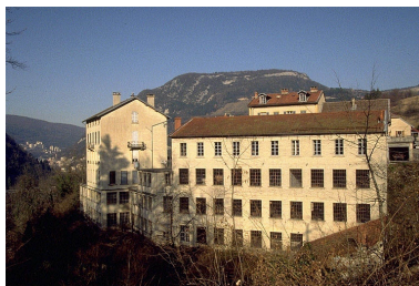
Usine vue du sud. Phot. Laurent Poupard IVR43_19913901128ZA
