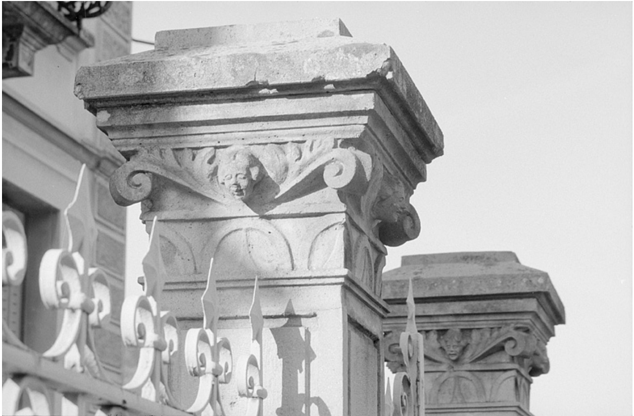
Chapiteau des piliers du portail d'entrée.
