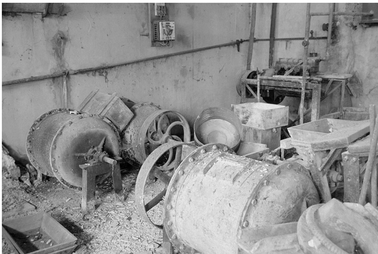
Moteurs électriques des équipes.
