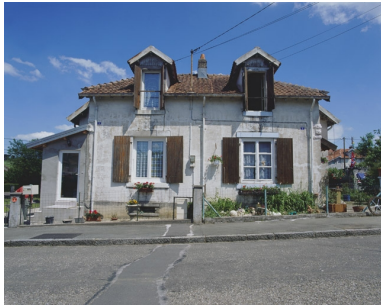
Maison jumelée à 2 travées : vue de face. Phot. Yves Sancey IVR43_20029000348XA
