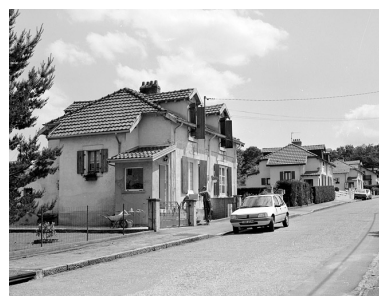
Maisons jumelées rue de Flandre. Phot. Yves Sancey IVR43_20029000344X
