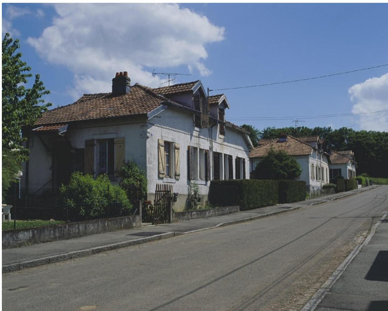
Maisons jumelées à 4 travées rue de Normandie.
