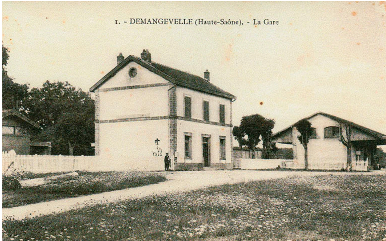
Demangevelle. La gare et la halle à marchandises. Carte postale.
