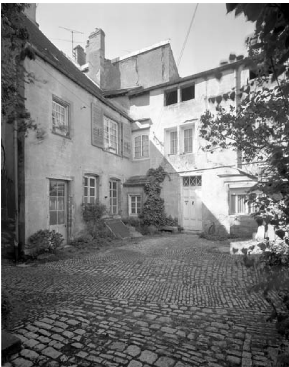
Façades sur cour : vue d'ensemble.
