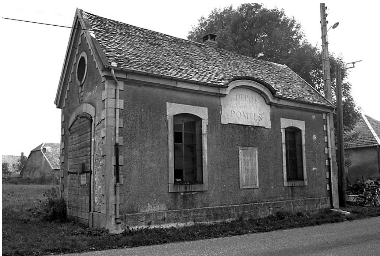
Façade antérieure vue de trois quarts gauche.
