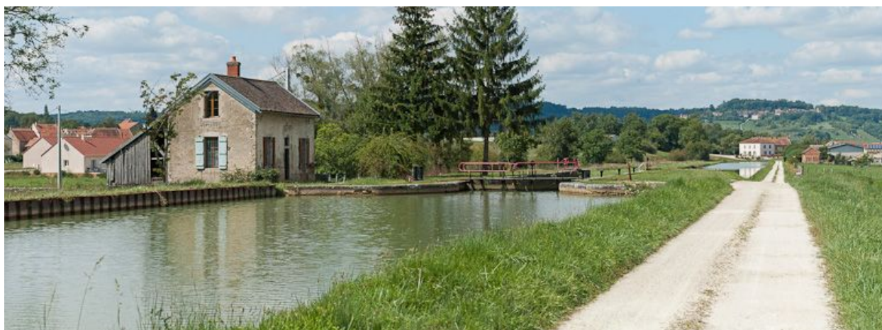
Vue du site d'écluse depuis l'amont.
