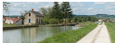
Vue du site d'écluse depuis l'amont. Phot. Pierre-Marie Barbe-Richaud IVR26_20112104017NUC4AQ
