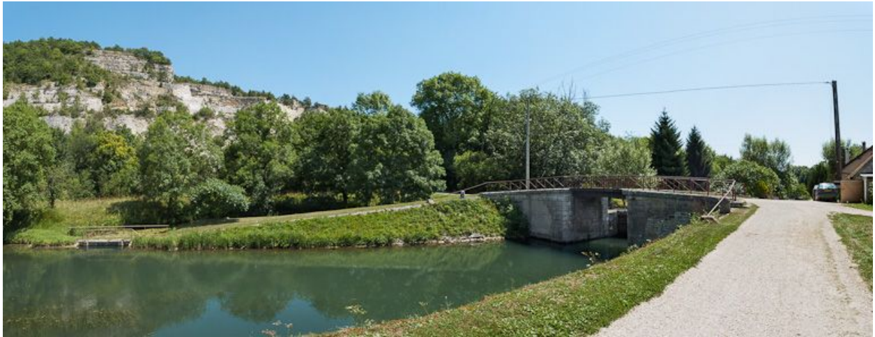
Pont vu d'aval.
