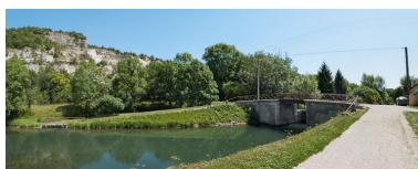
Pont vu d'aval. Phot. Pierre-Marie Barbe-Richaud IVR26_20128900357NUC4AQ
