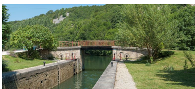
Pont vu du sas. Phot. Pierre-Marie Barbe-Richaud
