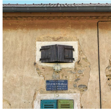
D  tail de la plaque   maill  e et de la frise en brique sous le toit. Phot. Pierre-Marie Barbe-Richaud IVR26_20137100457NUC4AQ
