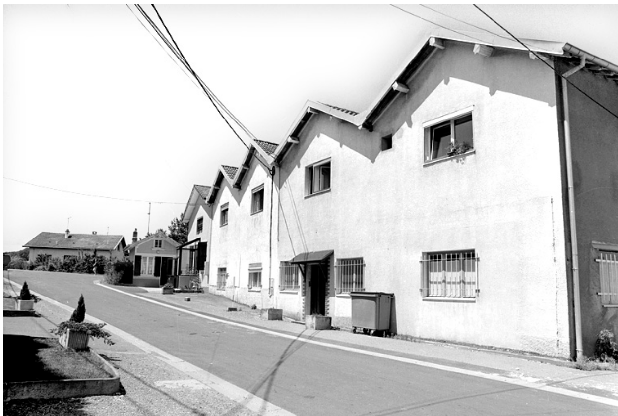
Murs-pignons des ateliers de fabrication.
