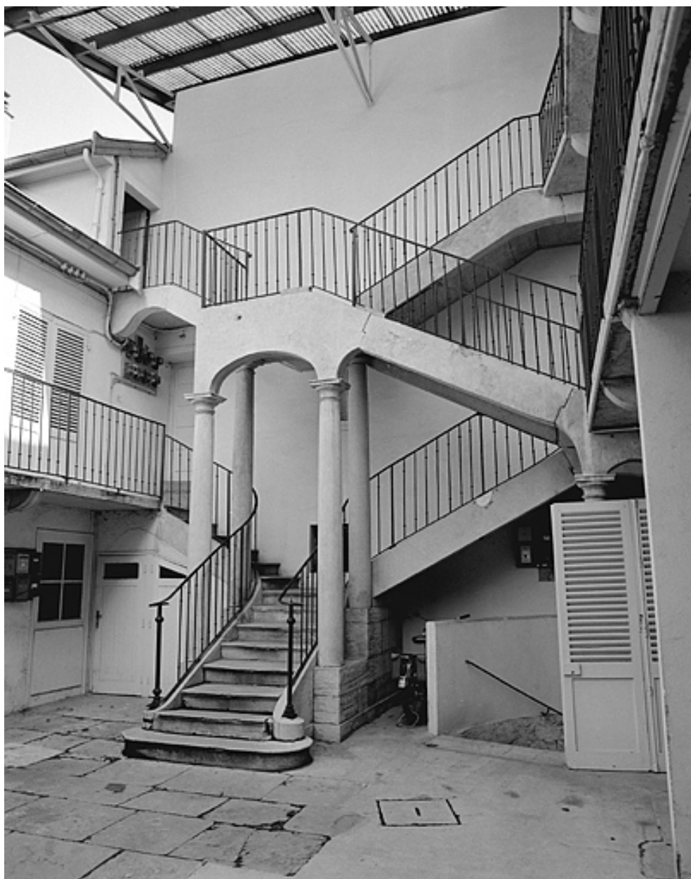
Maison, 74 rue Saint-Désiré, escalier sur cour.
