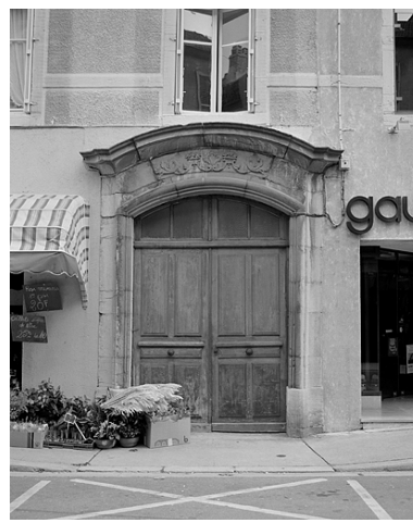
Maison, 15 rue Lafayette, porte cochère. Phot. Yves Sancey IVR43_19833900689X
