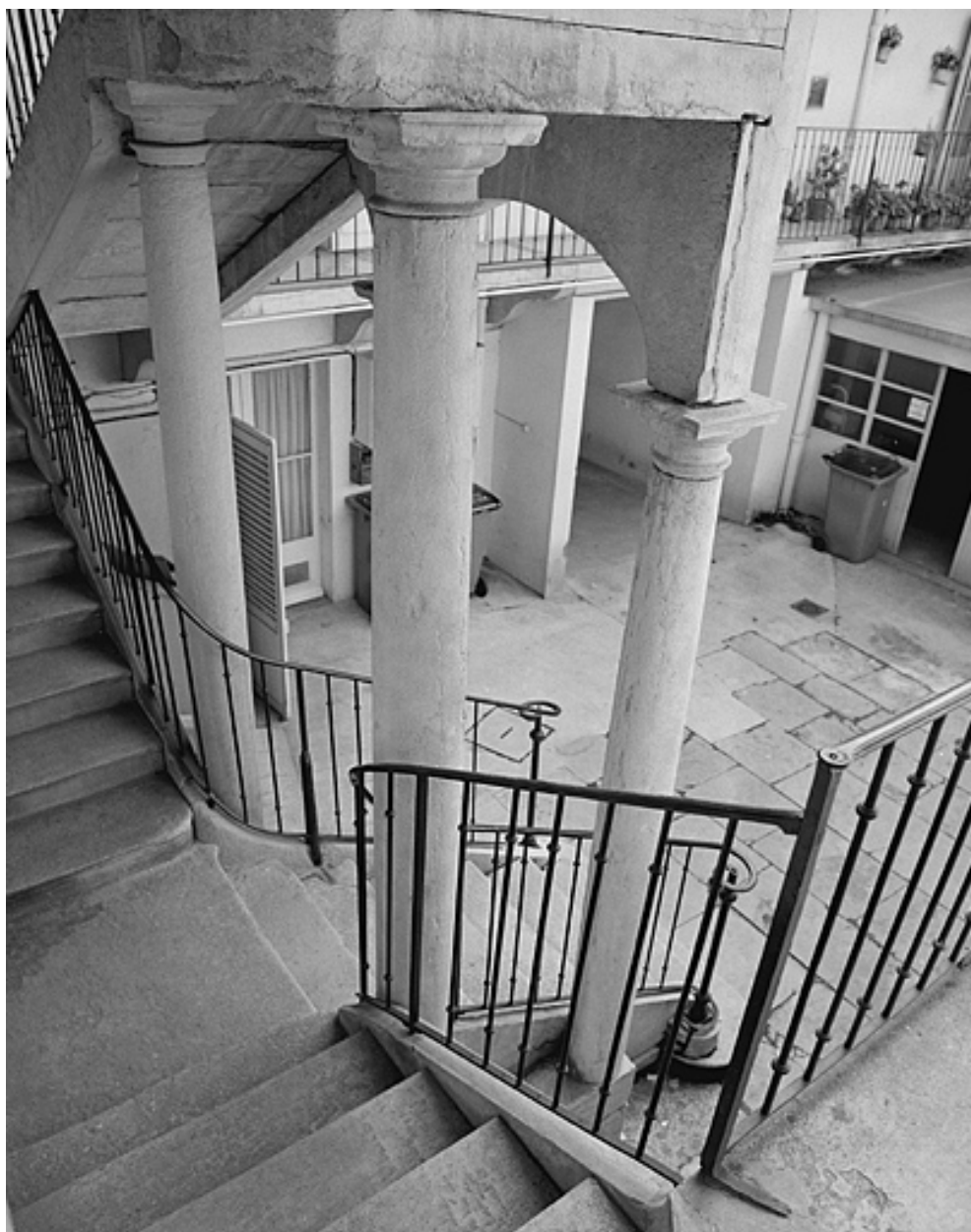
Maison, 74 rue Saint-Désiré, escalier sur cour, détail.
