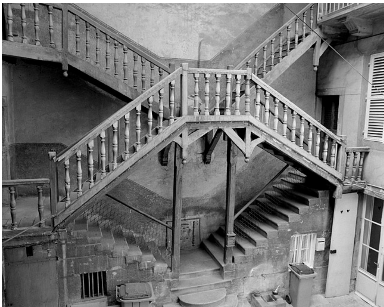
Maison, 17 rue Saint-Désiré, escalier sur cour.
