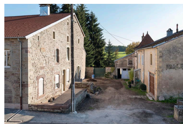
Vue du mur pignon ouest. Phot. Sonia Dourlot IVR43_20157001207NUC4A
