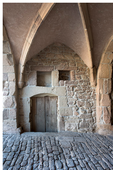
Détail des voûtes. Phot. Sonia Dourlot IVR43_20157001212NUC4A
