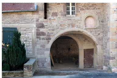
Le porche et l'accès à la grange. Phot. Sonia Dourlot IVR43_20157001209NUC4A
