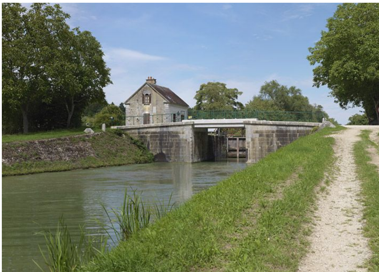
Le pont vu d'aval.
