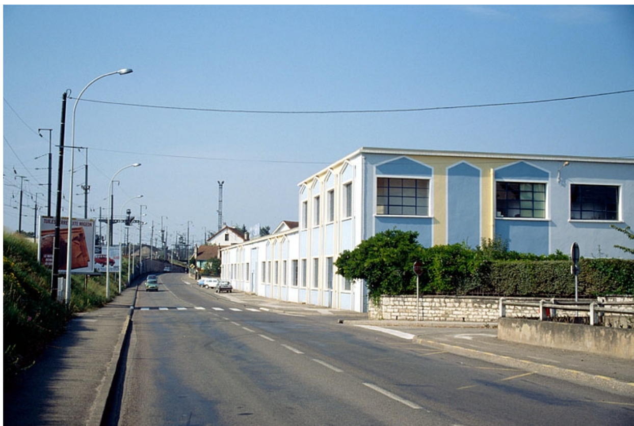
Usine 2, vue de trois quarts droit.
