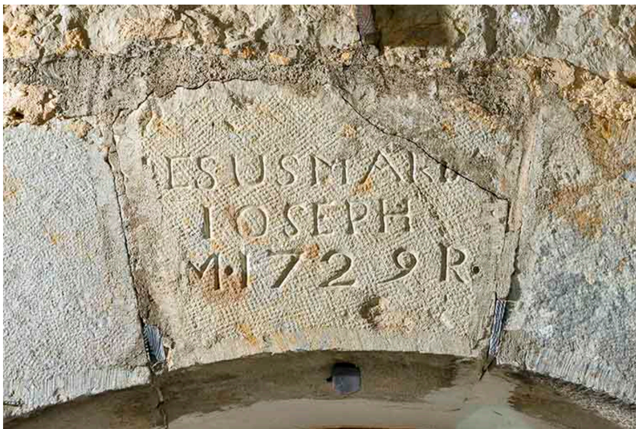
Détail d'une clef d'arcade de la porte du logement.(façade est).
