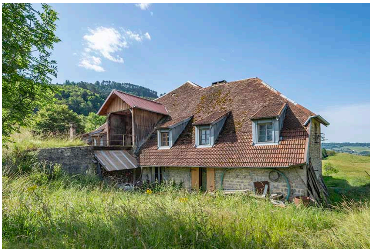
Vue depuis le nord.
