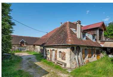
Vue d'ensemble depuis le nord-est. Phot. Jérôme Mongreville IVR43_20243900734NUC4A
