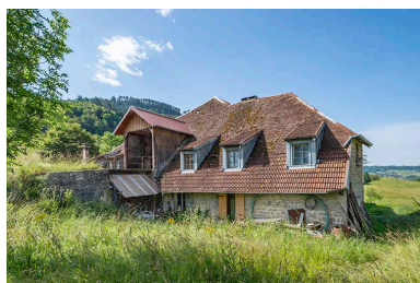
Vue depuis le nord. Phot. Jérôme Mongreville IVR43_20243900740NUC4A
