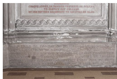
Détail du soubassement. Phot. Pierre-Marie Barbe-Richaud IVR26_20107100911NUC2A
