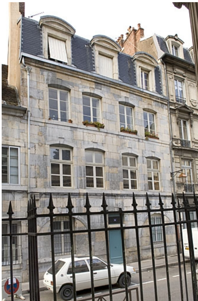
Vue d'ensemble depuis la rue.
