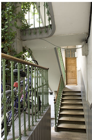
Détail de l'escalier à cage ouverte depuis la première volée. Phot. Jérôme Mongreville IVR43_20072501259NUC2A
