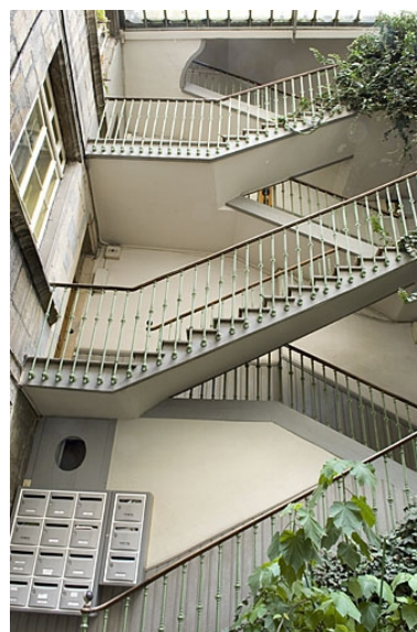
Vue de l'escalier à cage ouverte depuis la cour : partie supérieure. Phot. Jérôme Mongreville IVR43_20072501261NUC2A
