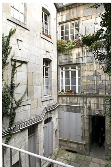
Façades sur cour depuis l'escalier à cage ouverte. Phot. Jérôme Mongreville IVR43_20072501257NUC2A
