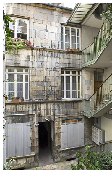
Vue d'ensemble de la façade sur cour du logis principal. Phot. Jérôme Mongreville IVR43_20072501258NUC2A
