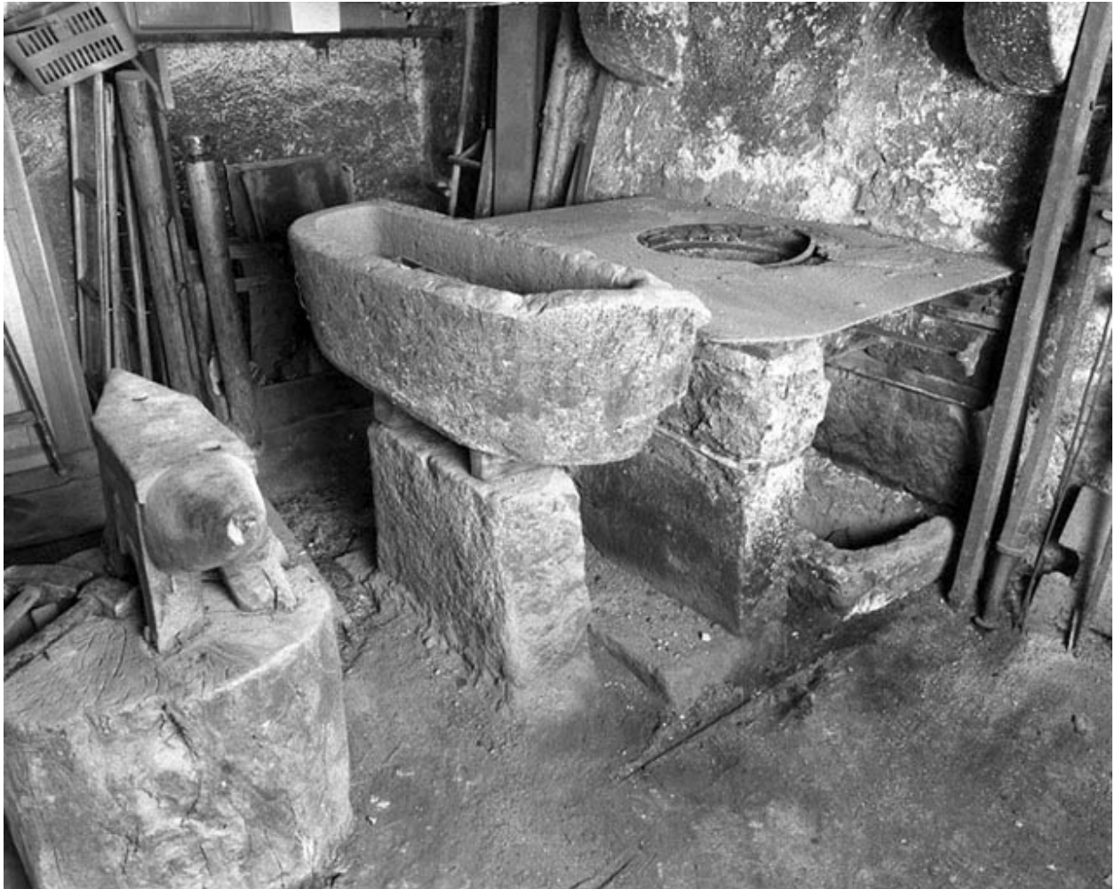
Intérieur de la forge, le foyer, l'enclume, le cendrier, la pierre à eau.
