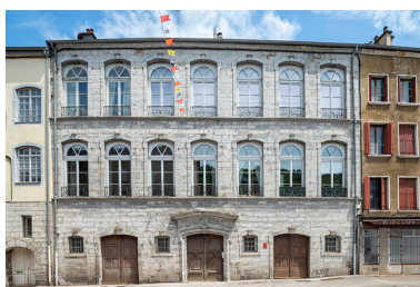
Façade antérieure vue de face. Phot. Jérôme Mongreville IVR43_20233900787NUC4A
