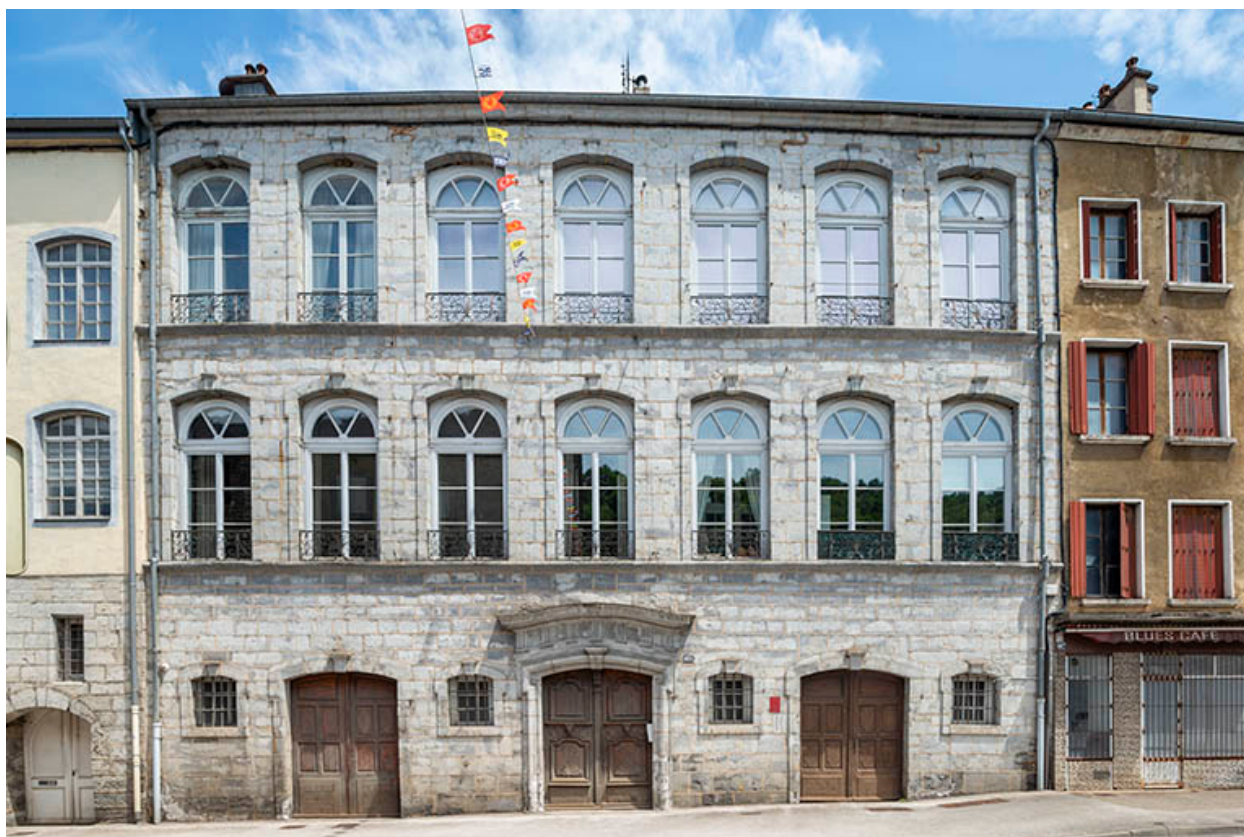
Façade antérieure vue de face.
