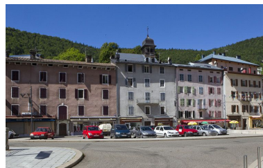
Le côté ouest. Phot. Yves Sancey IVR43_20103900683NUC2A
