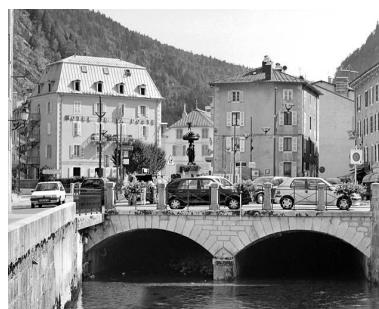
Le débouché de la Bienne, côté nord. Phot. Yves Sancey IVR43_20033900627X
