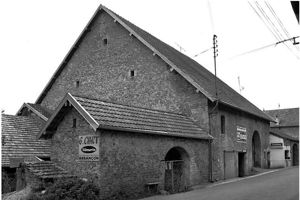
Façade antérieure vue de trois quarts gauche.
