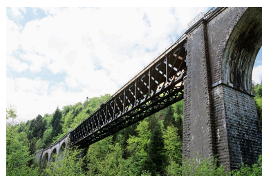
Travée métallique, depuis la route en amont. Phot. Yves Sancey IVR43_20053900109ZA
