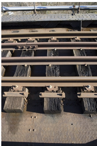
Détail de la voie sur la travée métallique. Phot. Yves Sancey IVR43_20073900066NUCA
