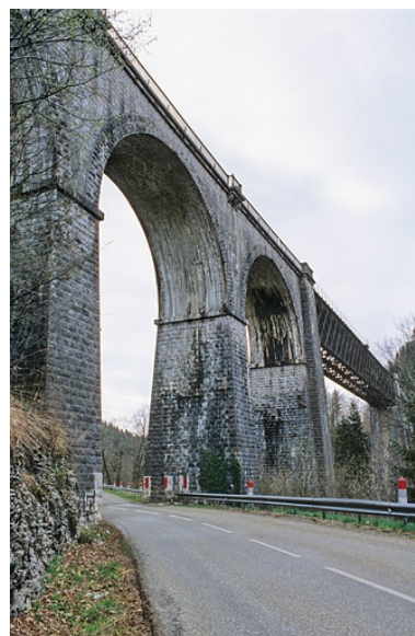
Partie en maçonnerie rive droite, depuis la route en aval. Phot. Yves Sancey IVR43_20053900085ZA
