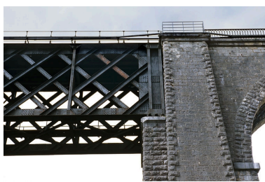
Détail de la jonction de la travée métallique et de l'arche en maçonnerie, rive droite. Phot. Yves Sancey IVR43_20053900114ZA
