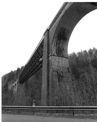
Troisième arche rive droite et travée métallique, vues par dessous (cadrage vertical). Phot. Yves Sancey IVR43_20053900080X
