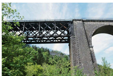
Jonction de la travée métallique et de l'arche en maçonnerie, rive droite. Phot. Yves Sancey IVR43_20053900110ZA
