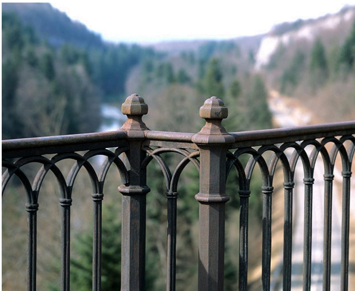
Détail du garde-corps : motif d'amortissement des potelets octogonaux.
