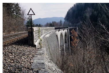
Extrémité rive gauche. Phot. Yves Sancey IVR43_20053900095ZA
