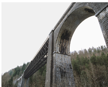
Troisième arche rive droite et travée métallique, vues par dessous. Phot. Yves Sancey IVR43_20053900079XA
