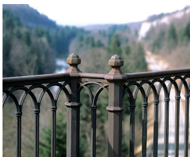
Détail du garde-corps : motif d'amortissement des potelets octogonaux. Phot. Yves Sancey IVR43_20053900097XA
