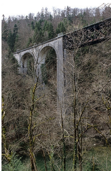
Partie en maçonnerie rive gauche et travée métallique, depuis la rive droite en amont. Phot. Yves Sancey IVR43_20053900116ZA
