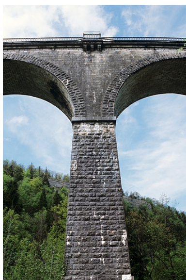
Pile en maçonnerie et refuge. Phot. Yves Sancey IVR43_20053900112ZA
