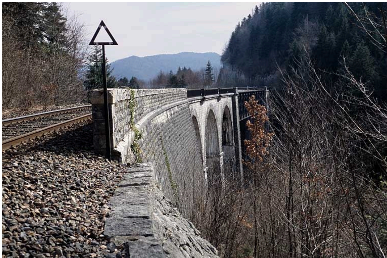
Extrémité rive gauche.
