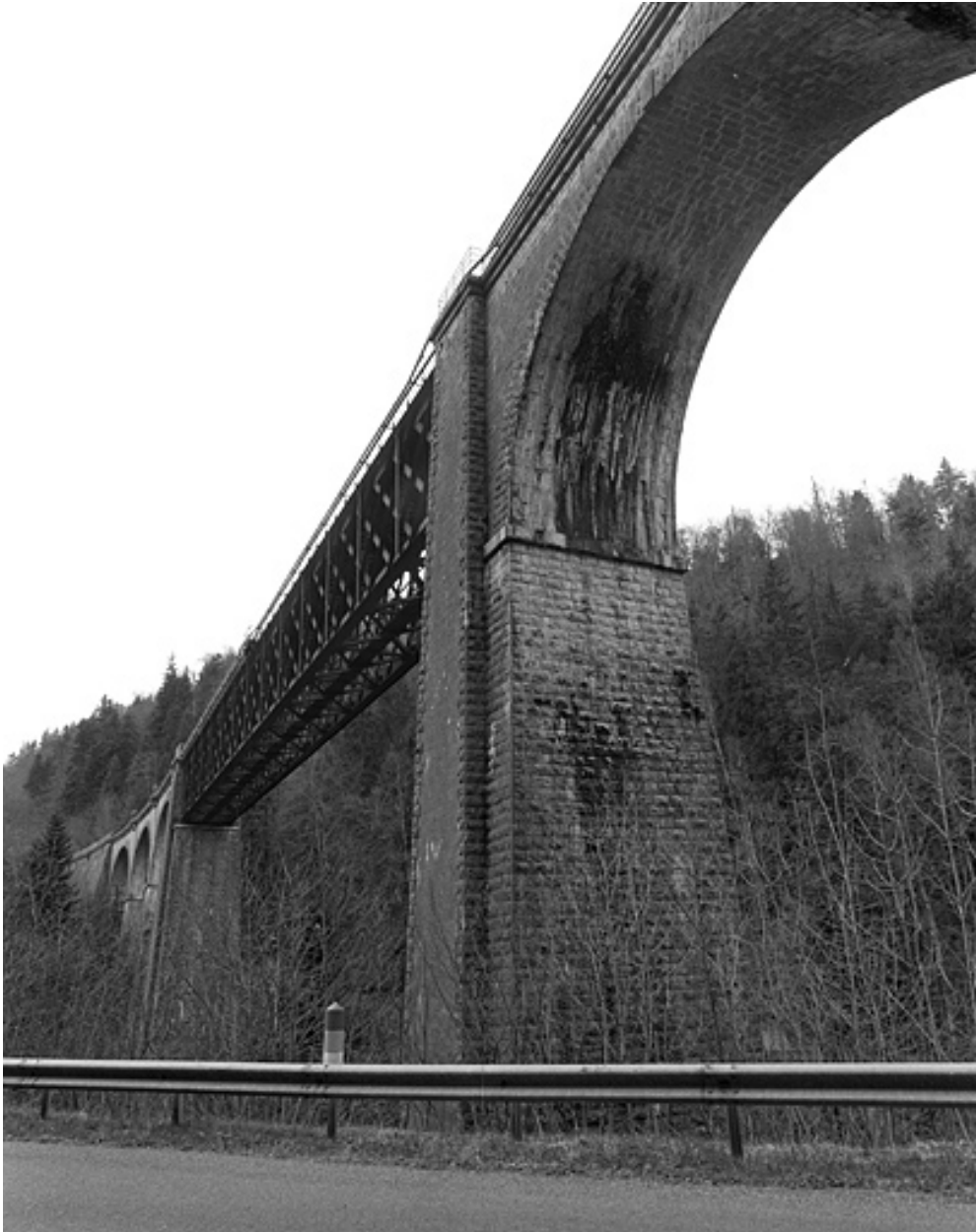
Troisième arche rive droite et travée métallique, vues par dessous (cadrage vertical).
