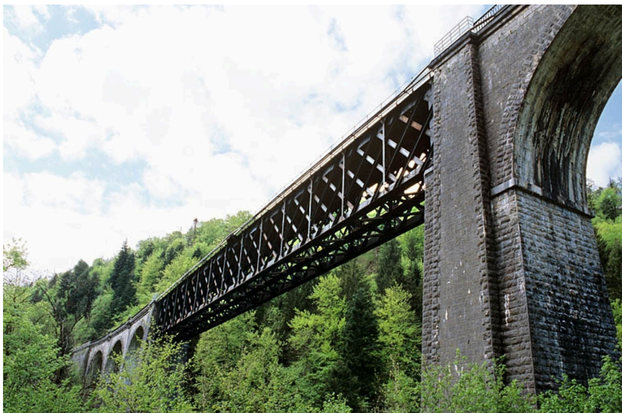
Travée métallique, depuis la route en amont.
