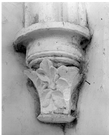
Chapiteau antérieur droit du chœur (décoré de larges feuilles imbriquées). Phot. Michel Rosso IVR26_19748900631X
