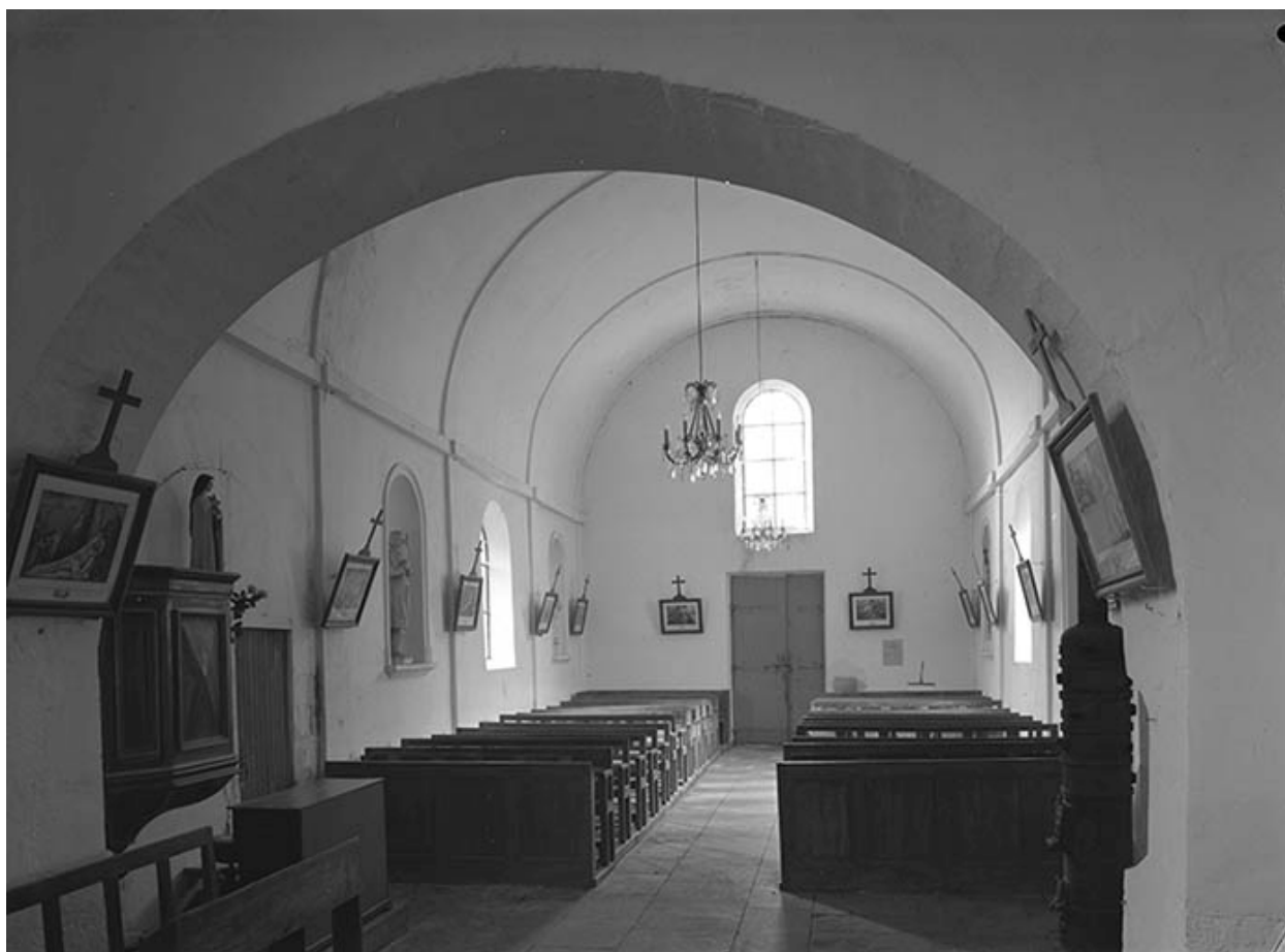
Vue intérieure prise depuis le choeur.
