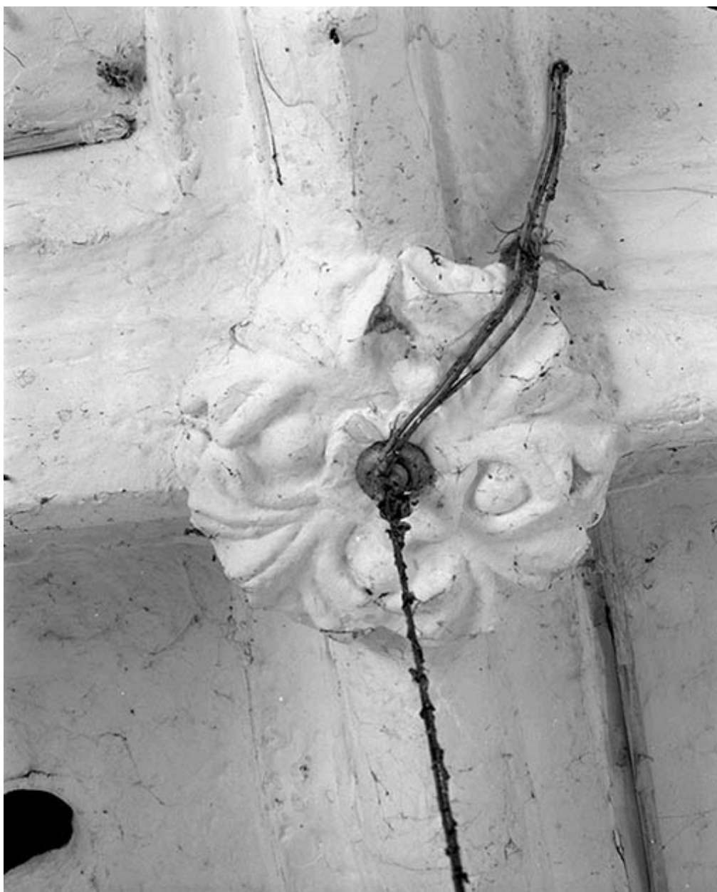
Détail : clef de voûte, dans le chœur.
