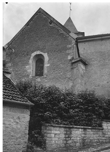
Façade du transept nord (?). Phot. Michel Rosso IVR26_19748900637V
