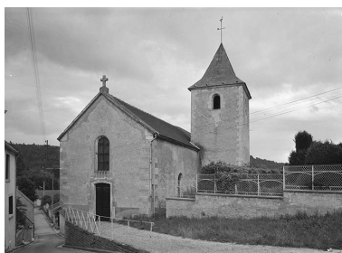
Façade occidentale avec clocher. Phot. Michel Rosso IVR26_19748900636V
