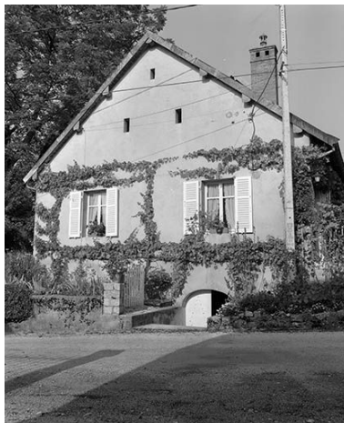
Face latérale gauche. Phot. Yves Sancey IVR43_19802501069X
