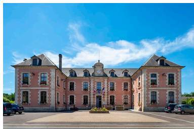
Façade nord-est, vue d'ensemble de face.
