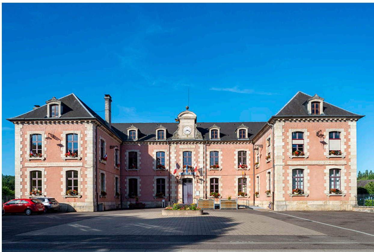
Façade nord-est, vue d'ensemble de face.
