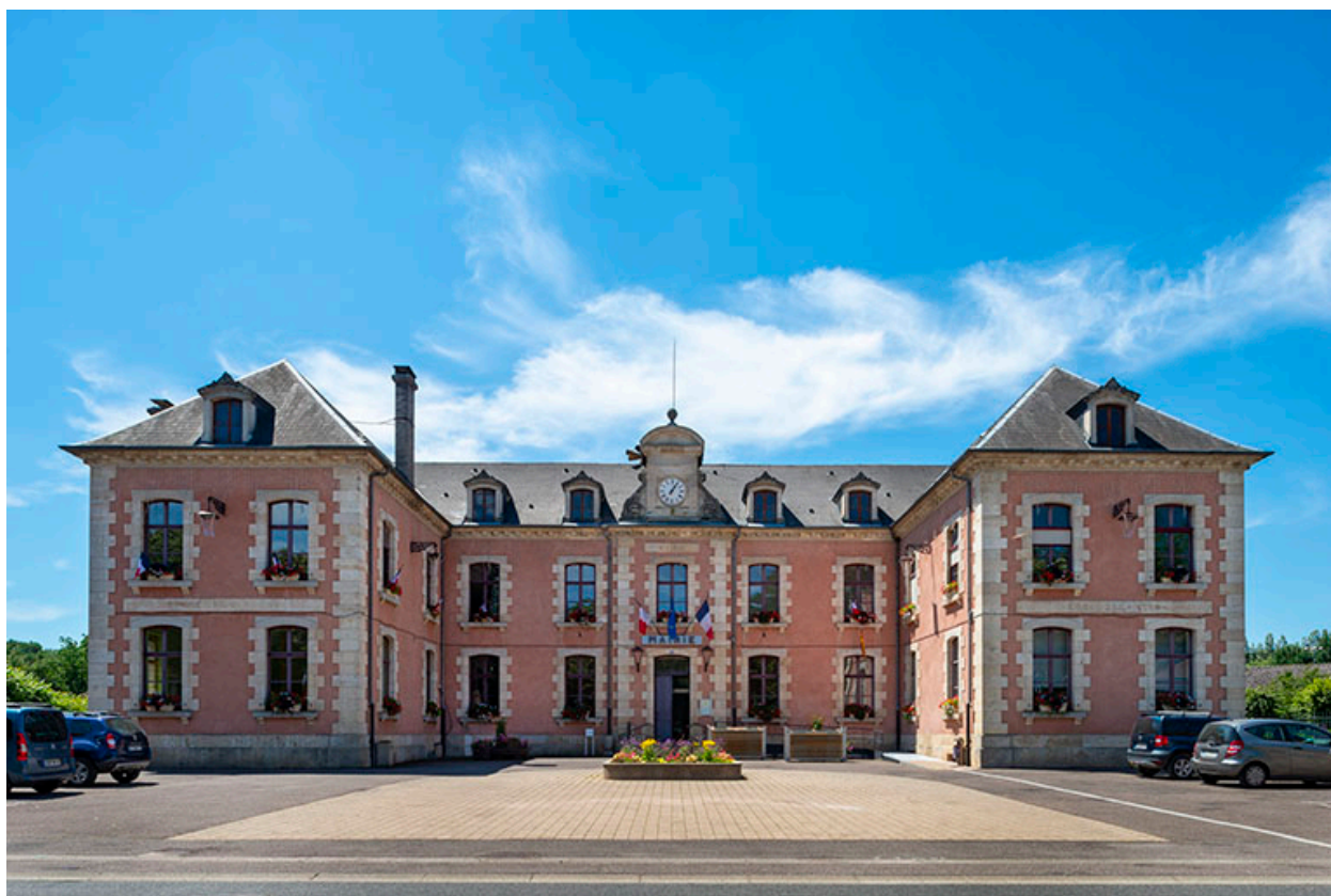
Façade nord-est, vue d'ensemble de face.
