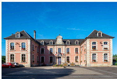
Façade nord-est, vue d'ensemble de face.
