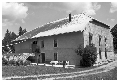
Façade postérieure et face gauche. Phot. Jérôme Mongreville IVR43_20003900309X
