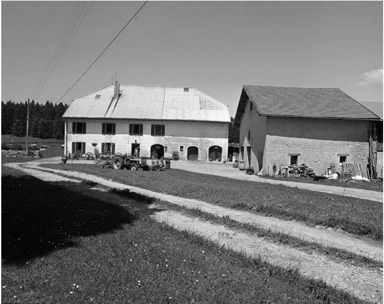
Vue éloignée de la façade antérieure.
