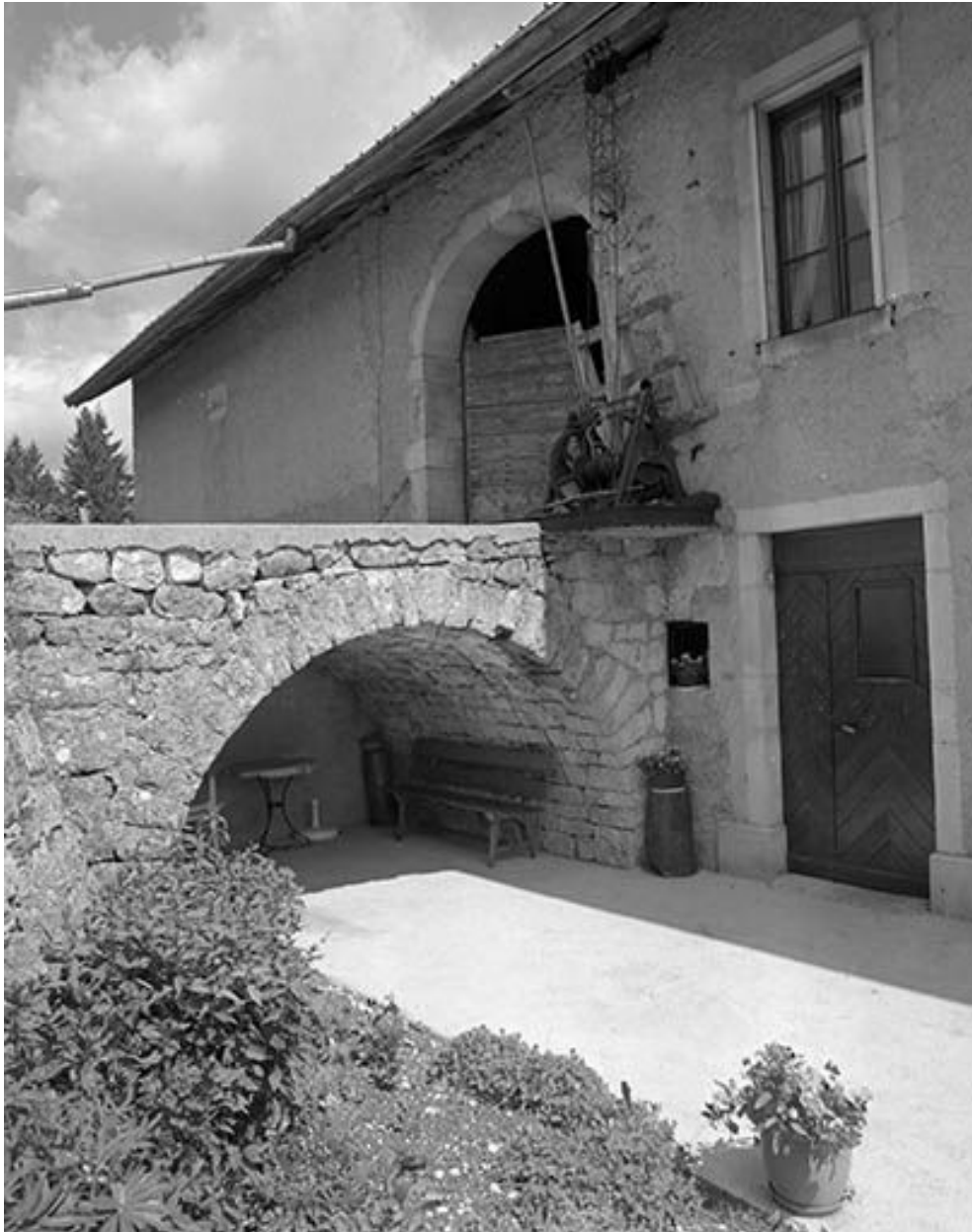
Pont de grange haute.
