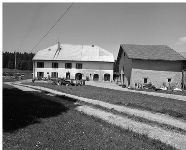
Vue éloignée de la façade antérieure. Phot. Jérôme Mongreville IVR43_20003900307X
