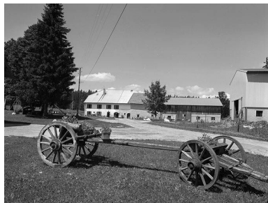
Vue de situation. Phot. Jérôme Mongreville IVR43_20003900308X
