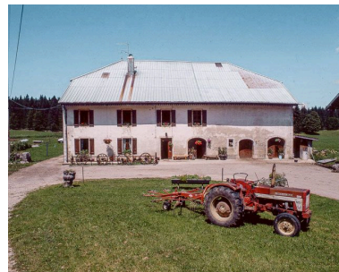
Façade antérieure. Phot. Jérôme Mongreville IVR43_20003900342XA
