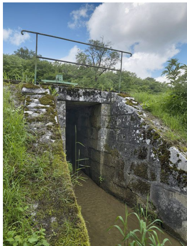
Déversoir rive gauche : sortie du déversoir. Phot. Thierry Kuntz IVR26_20122102307NUC4A
