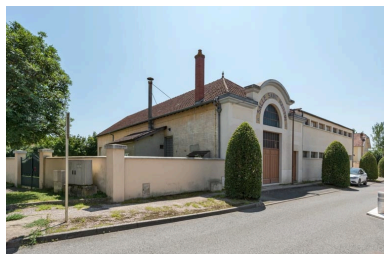
Vue d'ensemble, de trois quarts gauche. Phot. Pierre-Marie Barbe-Richaud IVR26_20212100084NUC4A
