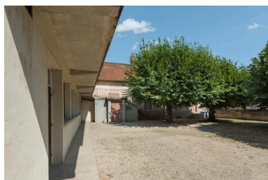
Cinéma : façade latérale droite. Phot. Pierre-Marie Barbe-Richaud IVR26_20212100086NUC4A
