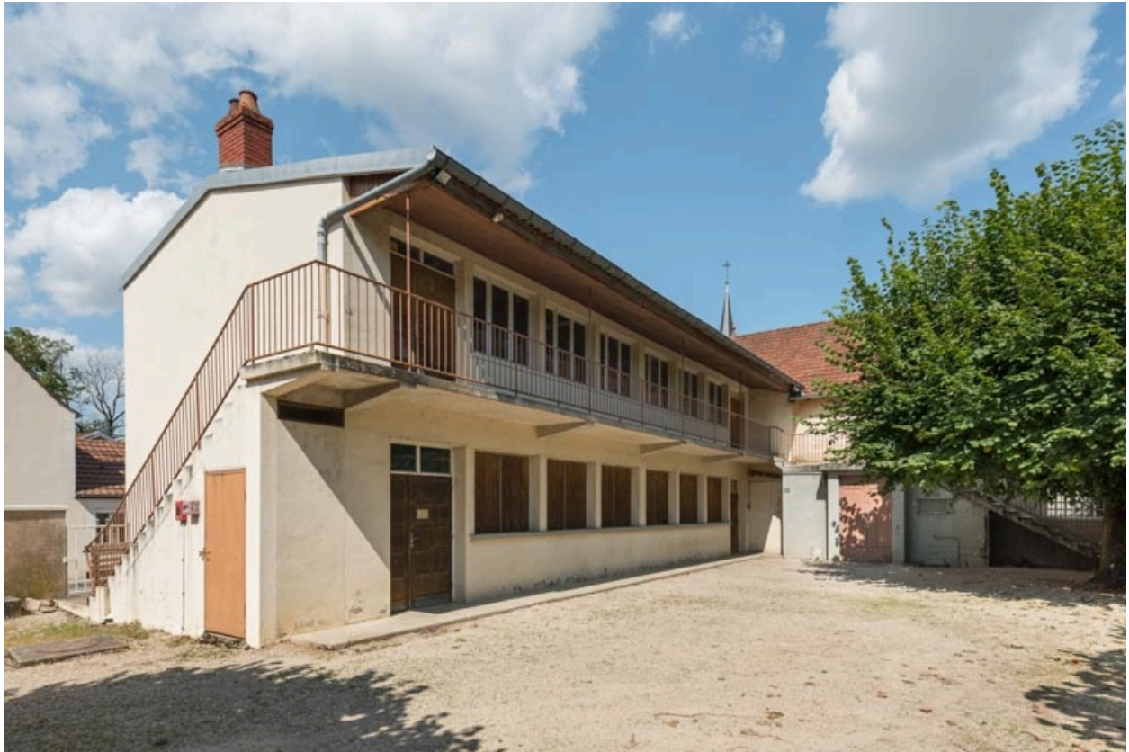
Aile (à usage de salles de catéchisme et de sport) : façades postérieure et latérale gauche.
