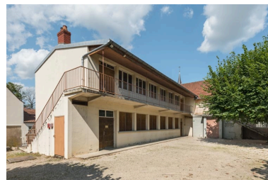
Aile (à usage de salles de catéchisme et de sport) : façades postérieure et latérale gauche. Phot. Pierre-Marie Barbe-Richaud IVR26_20212100087NUC4A
