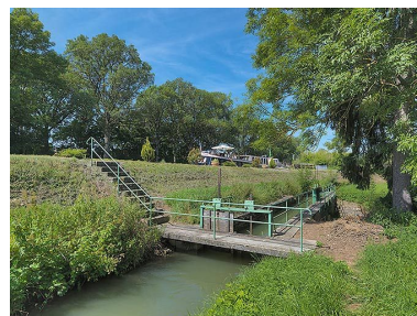
La rigole avec les vannes de régulation. A gauche, le talus du canal. Phot. Thierry Kuntz IVR26_20122102074NUC4A
