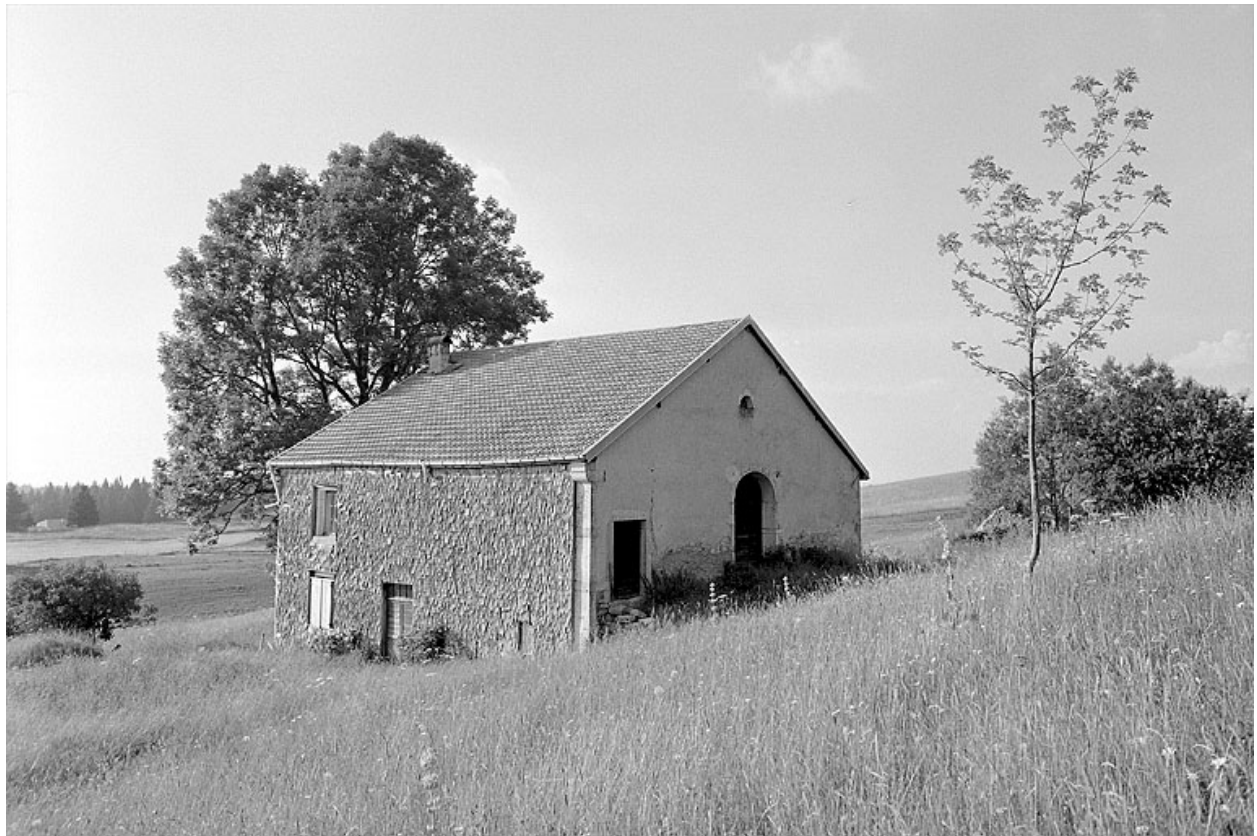
Façade antérieure et face droite.
