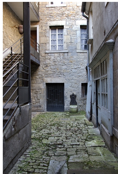
Vue d'ensemble du logis secondaire sur cour.
