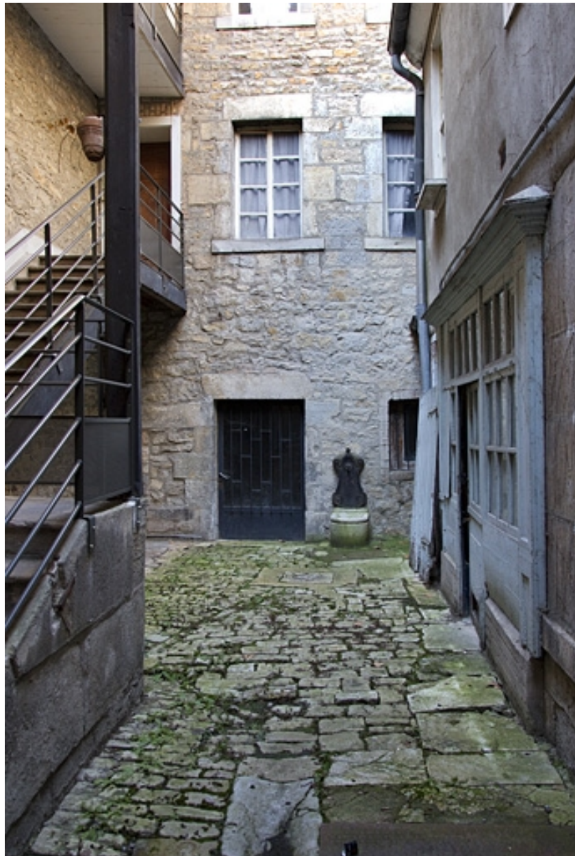
Vue d'ensemble du logis secondaire sur cour.
