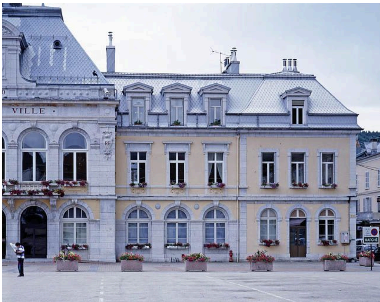
Elévation antérieure : partie droite.
