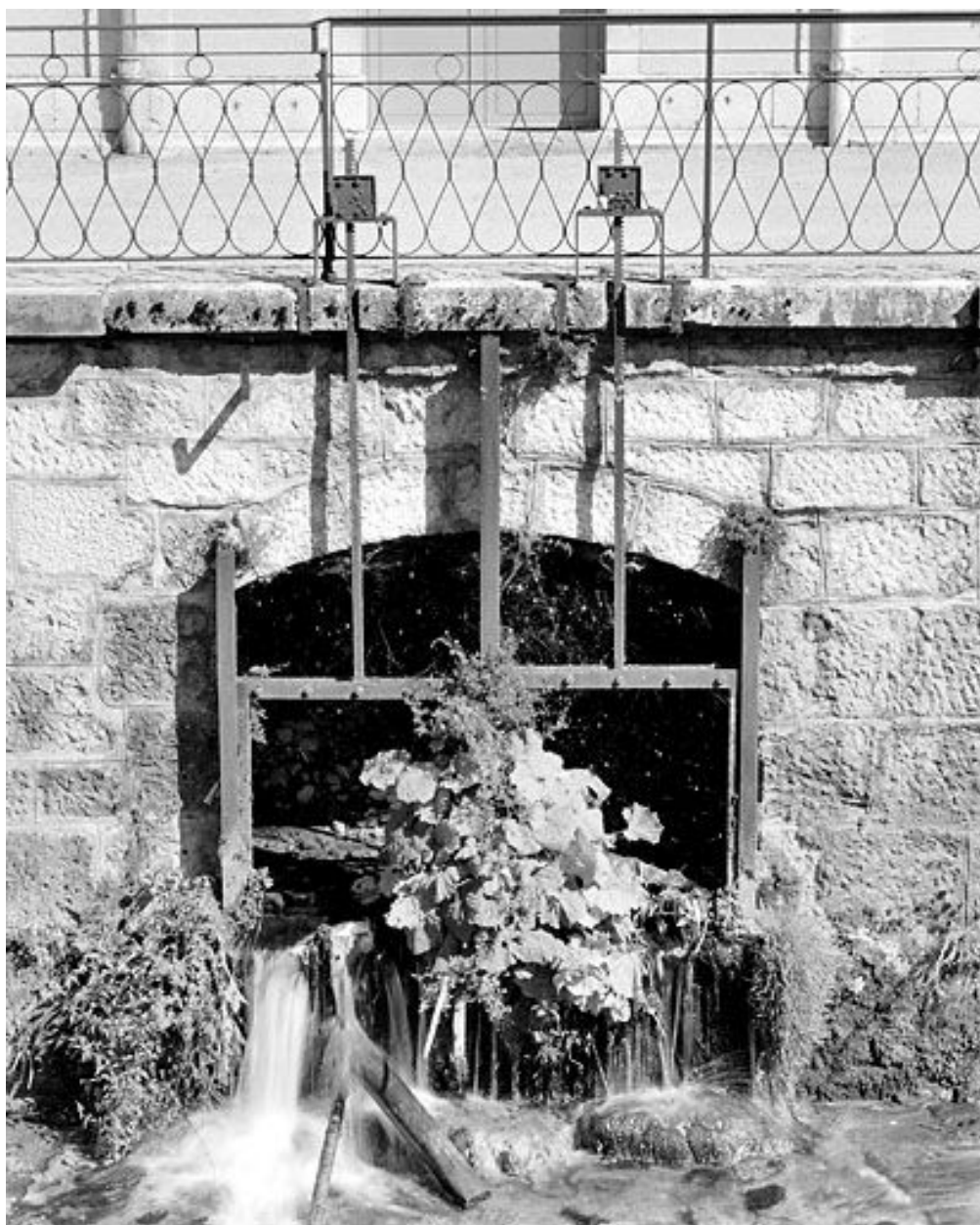
Aile latérale gauche : détail d'une prise d'eau du canal d'amenée passant sous le bâtiment.
