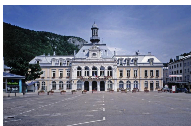
Elévation antérieure. Phot. Jérôme Mongreville IVR43_20003900374VA
