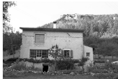
Façade latérale gauche. Phot. Laurent Poupard IVR43_19903901235Z
