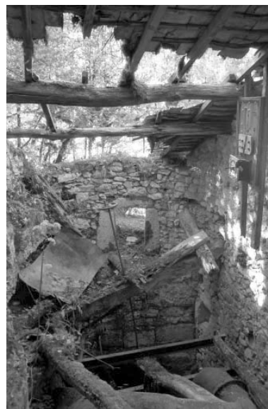
Site de la cascade : intérieur du bâtiment d'eau. Phot. Laurent Poupard IVR43_19903901238Z
