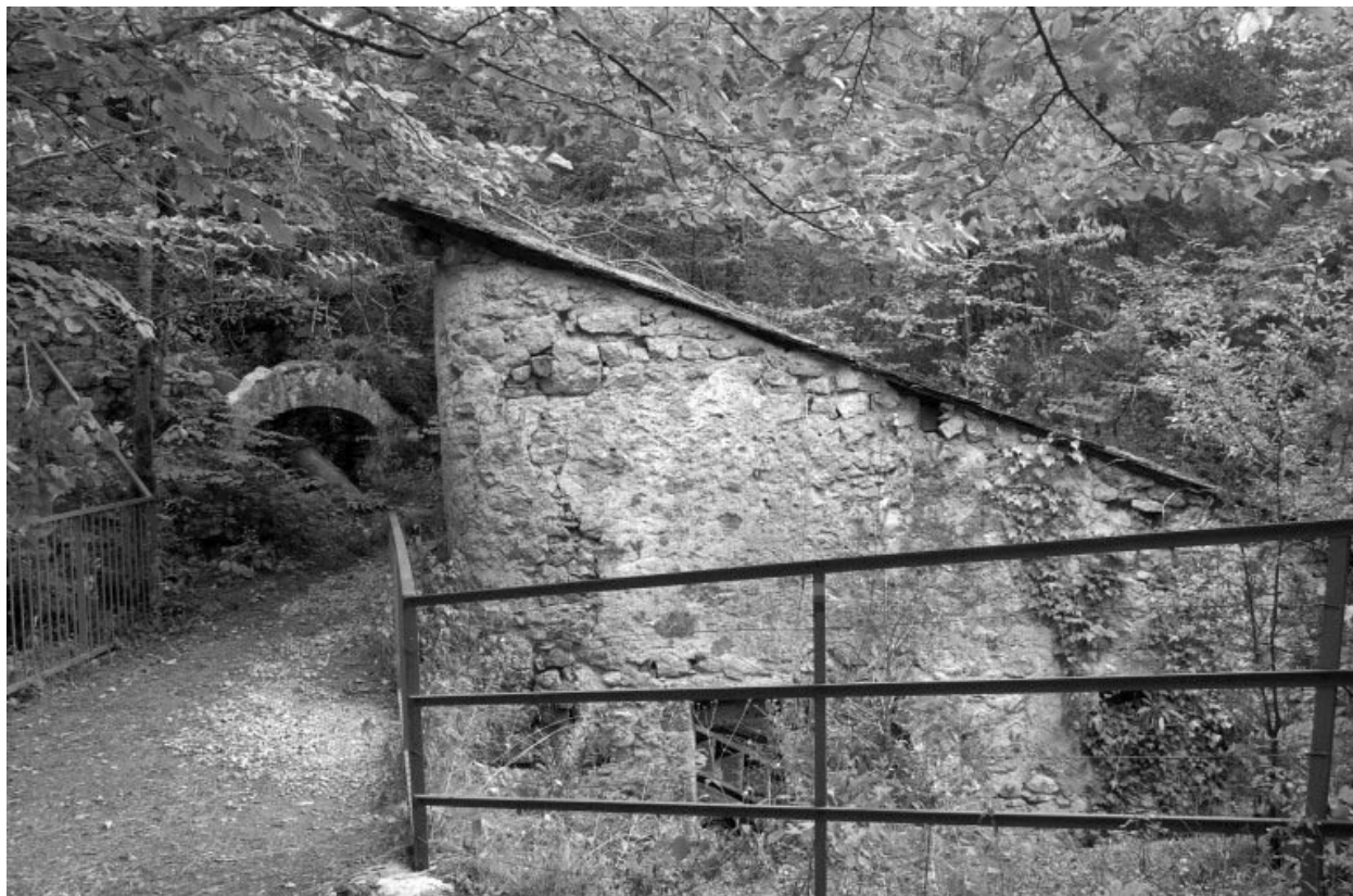
Site de la cascade : bâtiment d'eau.
