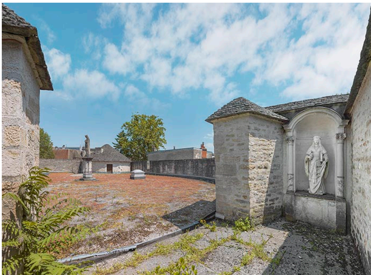
La plateforme supérieure de la tour.
