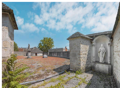
La plateforme supérieure de la tour. Phot. Thierry Kuntz IVR26_20242100312NUC4A
