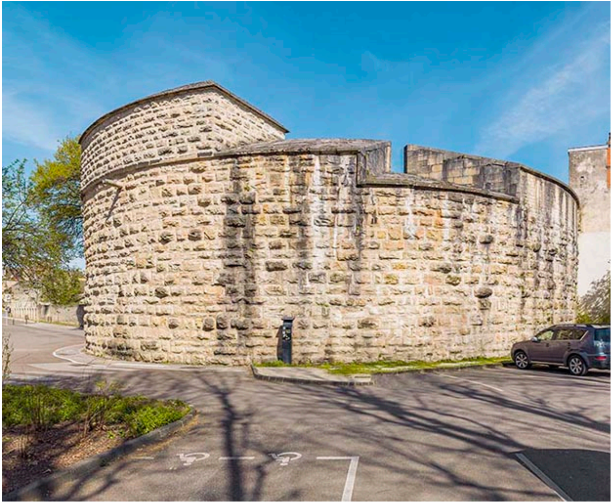
La tour et son parapet crénelé.
