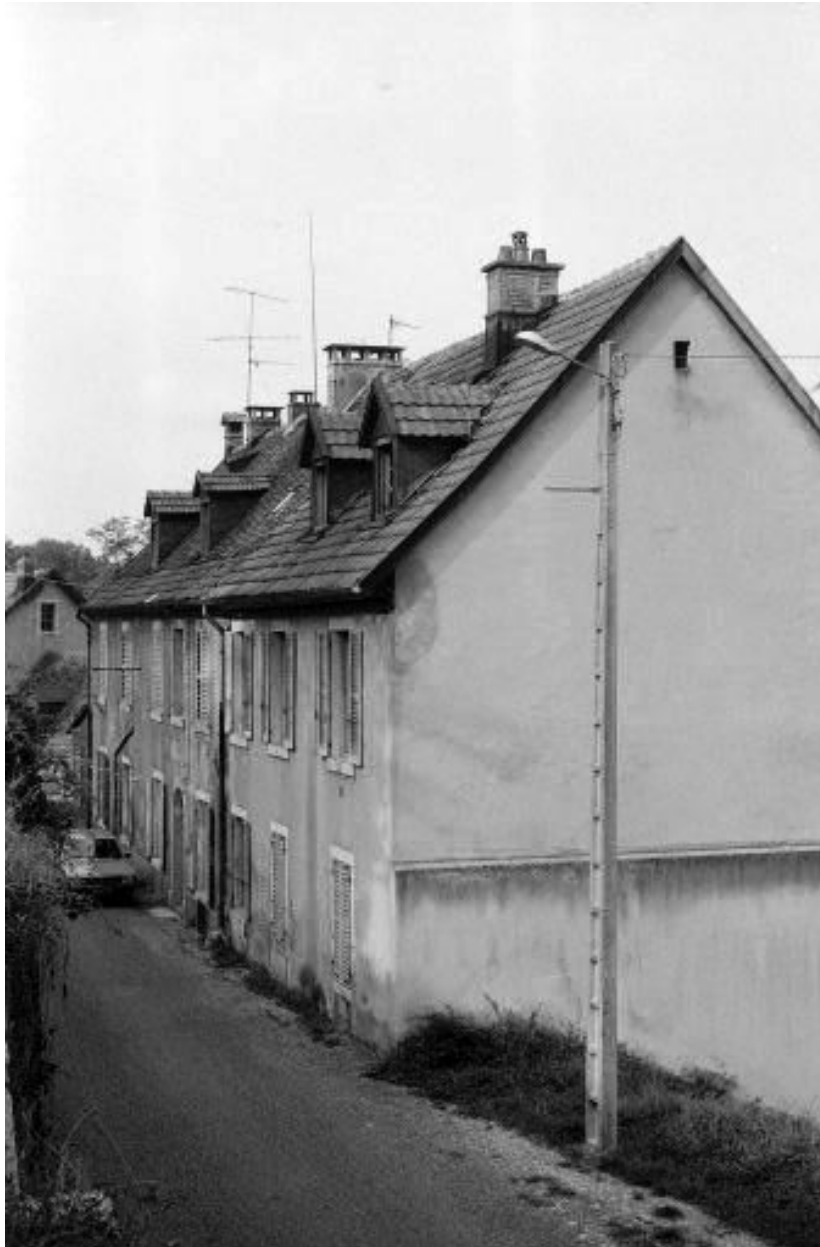
Façades antérieure et latérale droite.
