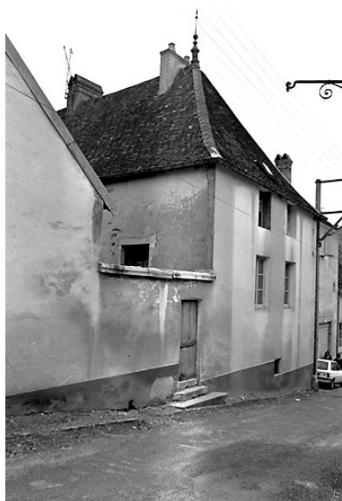
Façade sur rue Phot. Dominique Dominguez IVR43_19807000528X
