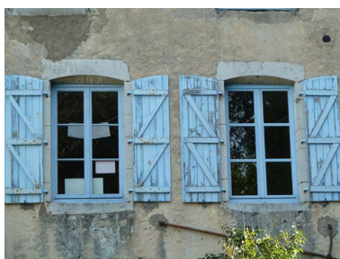
Détail des baies de la façade ouest Phot. Sabrina Dalibard IVR43_20137000820NUC2A
