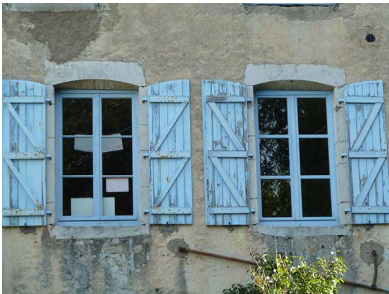
Détail des baies de la façade ouest
