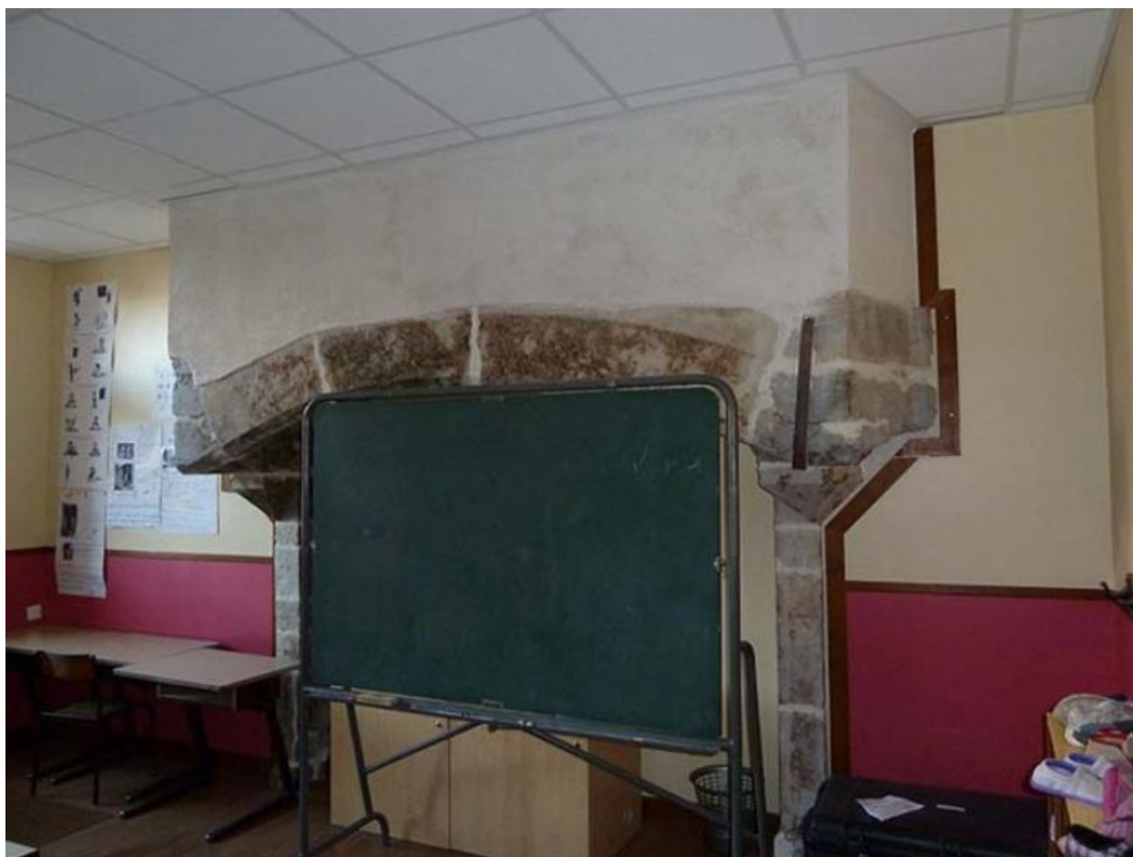
Cheminée monumentale, adossée à la précédente
