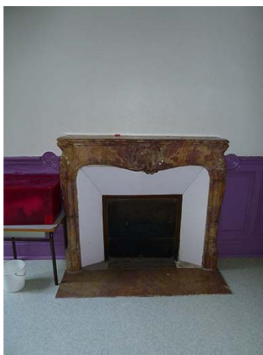
Cheminée en marbre de la partie sud-ouest Phot. Sabrina Dalibard IVR43_20137000829NUC2A
