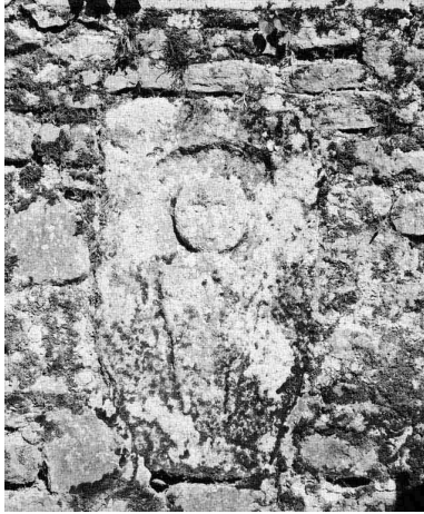
Vue d'ensemble. Phot. Jean-Luc Duthu IVR26_19802100806X
