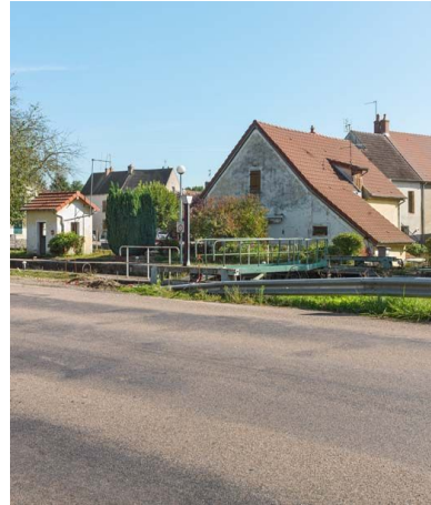
Vue rapprochée de l'écluse. Phot. Pierre-Marie Barbe-Richaud IVR26_20177100370NUC2A
