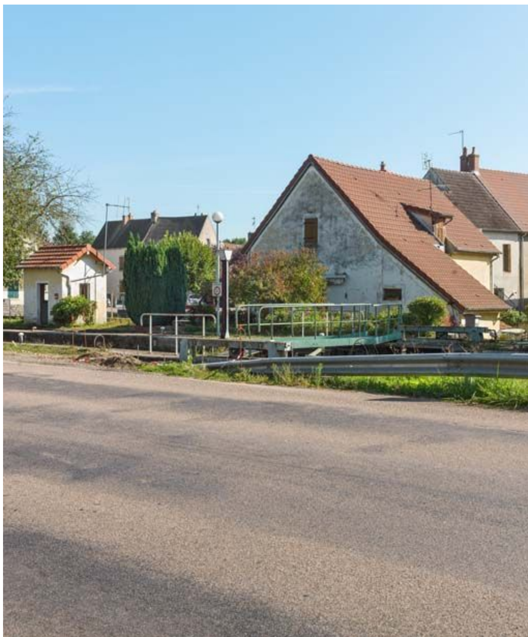
Vue rapprochée de l'écluse.
