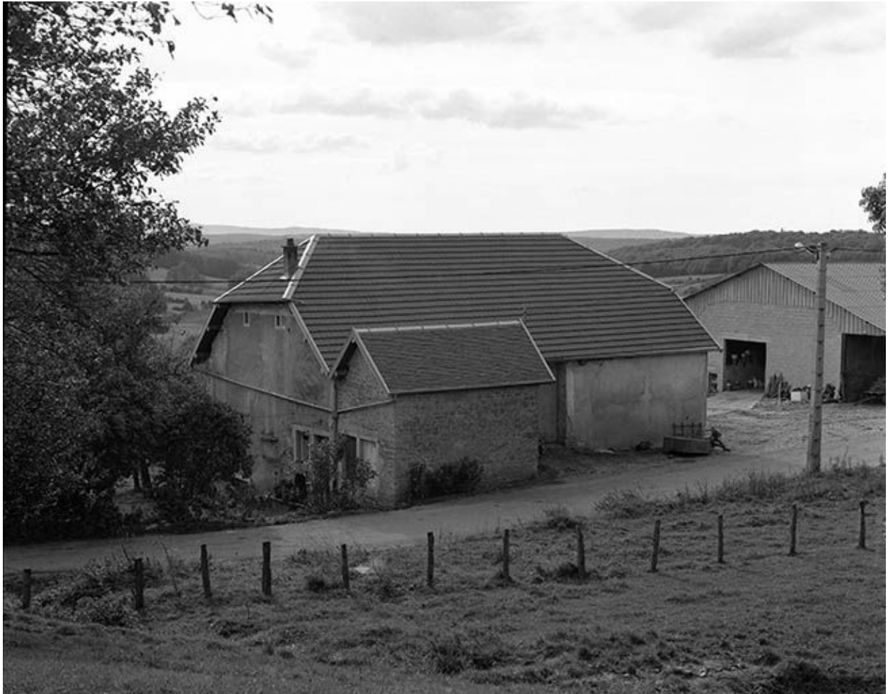
Façade antérieure et face latérale droite.
