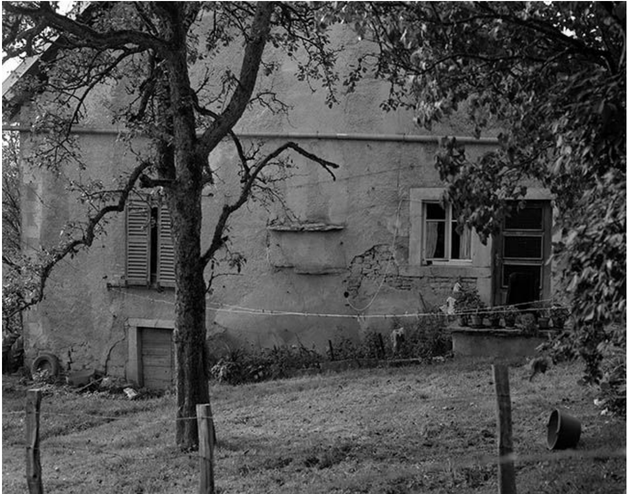
Détail de la façade antérieure.
