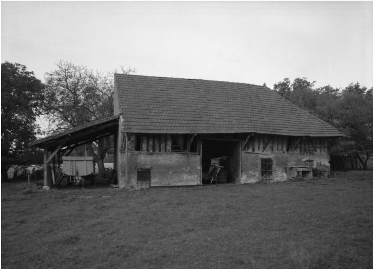
Bâtiment des dépendances.
