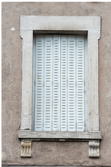
Détail d'une baie, premier étage. Phot. Jérôme Mongreville IVR43_20177000985NUC4A
