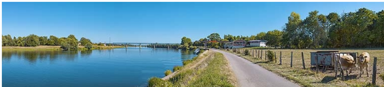
Le port de Gergy, vu d'amont. Le pont Boucicaut en arrière-plan.
