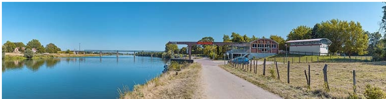
Le port de Gergy, vu d'amont. Le pont Boucicaut en arrière-plan.
