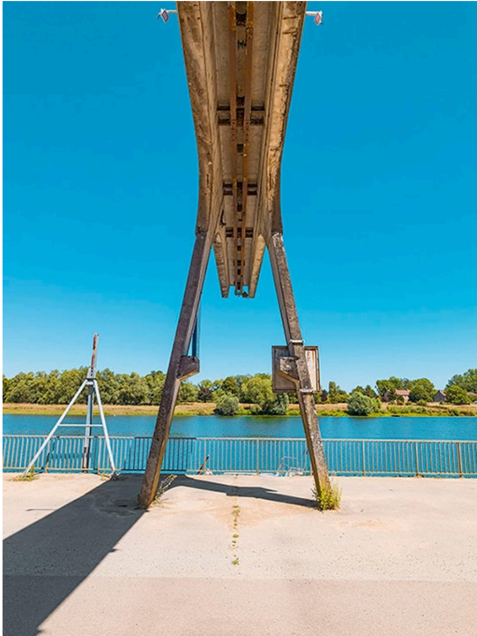
Portique de déchargement avec poulie.
