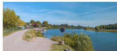
Vue d'ensemble du port de Gergy, depuis la rampe aval. Phot. Thierry Kuntz IVR26_20207100298NUC4A
