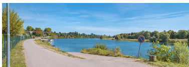
Vue d'ensemble du port de Gergy. Phot. Thierry Kuntz IVR26_20207100297NUC4A
