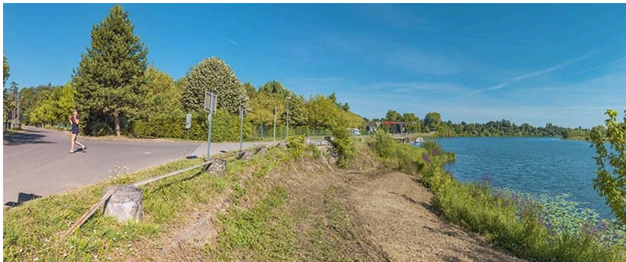
Perrés en aval du port de Gergy.
