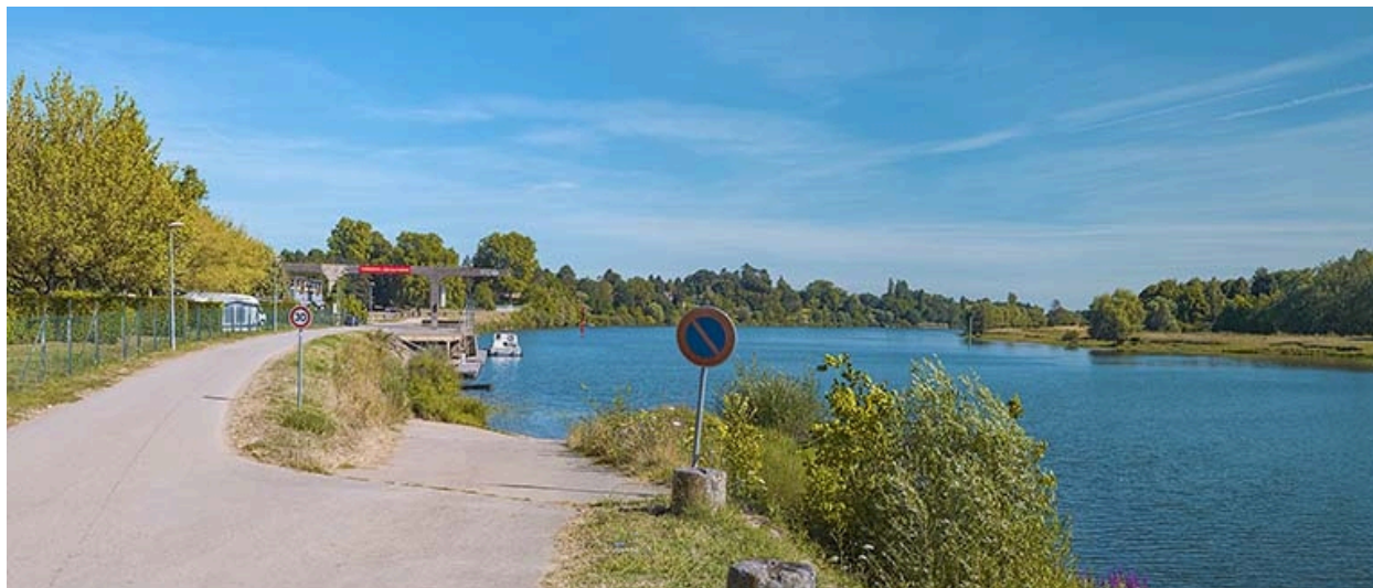
Vue d'ensemble du port de Gergy, depuis la rampe aval.
