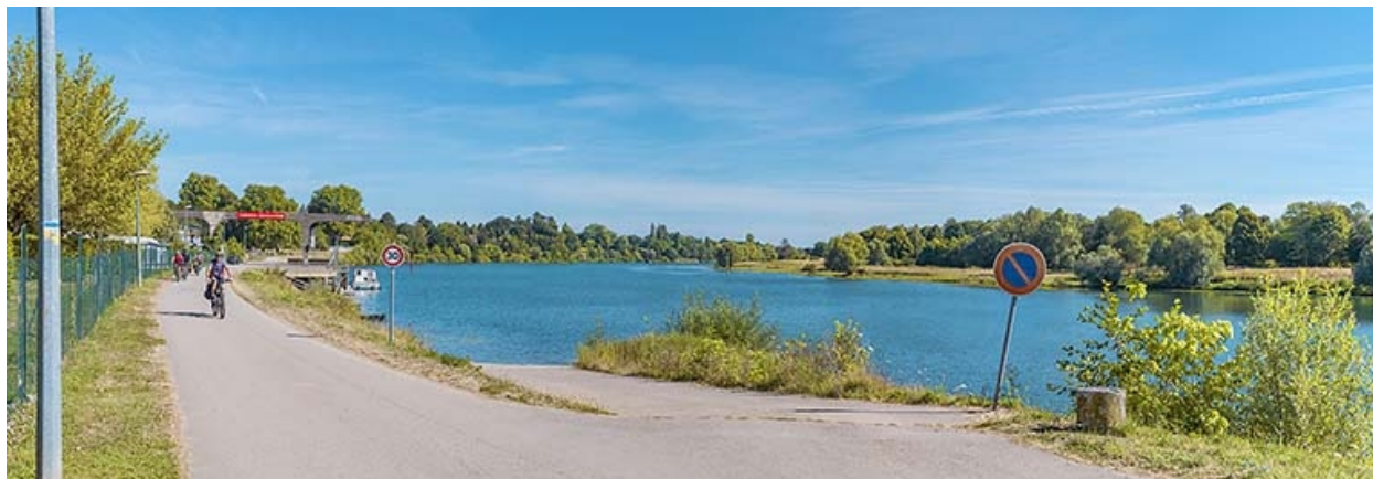
Vue d'ensemble du port de Gergy, depuis la rampe aval.
