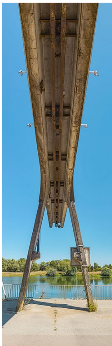
Portique de déchargement avec poulie.
