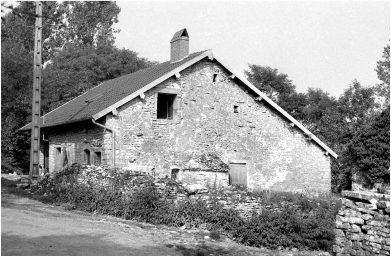
Façade latérale droite.
