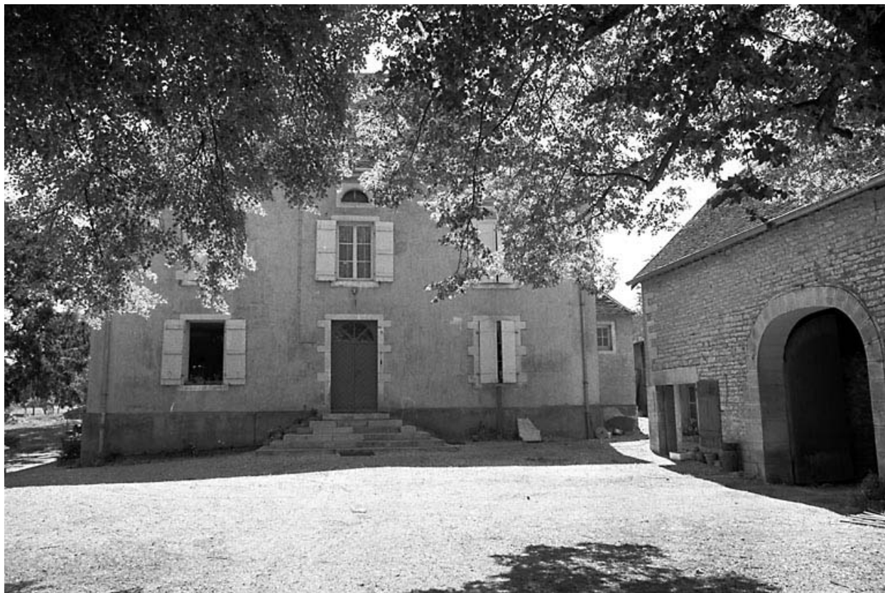
Vue des bâtiments depuis la cour.
