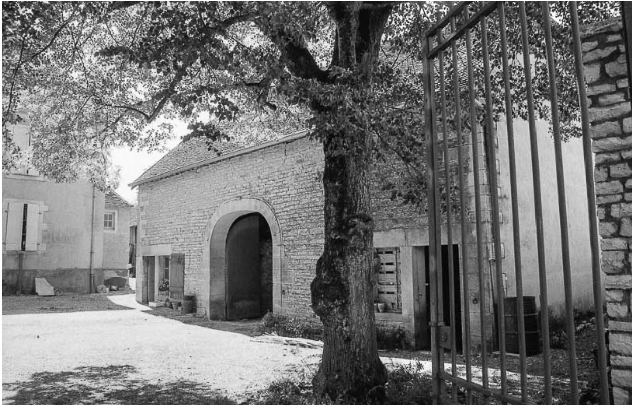
Dépendance à droite dans la cour.
