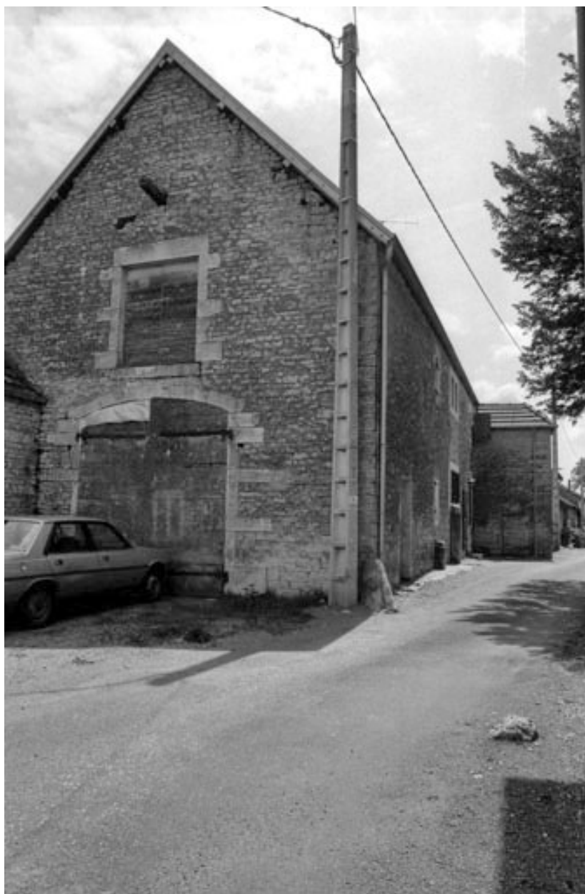
Pignon de l'habitation avec remise.
