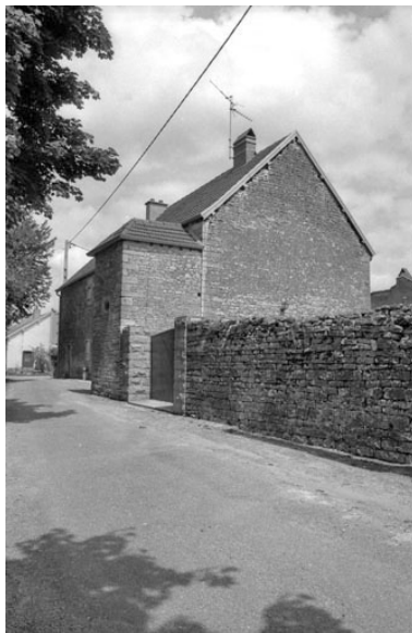
Façade latérale droite Phot. Bernard Lardière IVR43_19817000502Z
