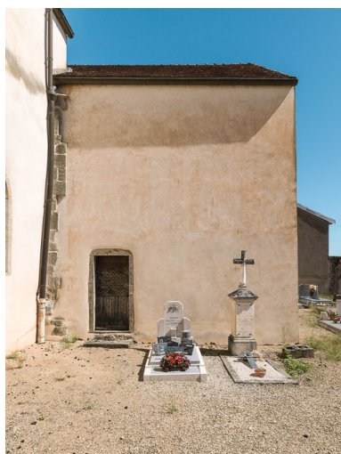
Elévation ouest de la chapelle sud. Phot. Pierre-Marie Barbe-Richaud IVR26_20167100066NUC2A
