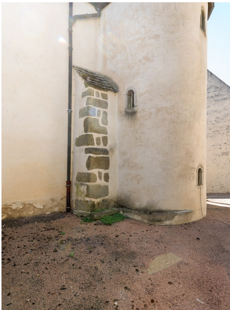
Détail de la tourelle d'escalier.
