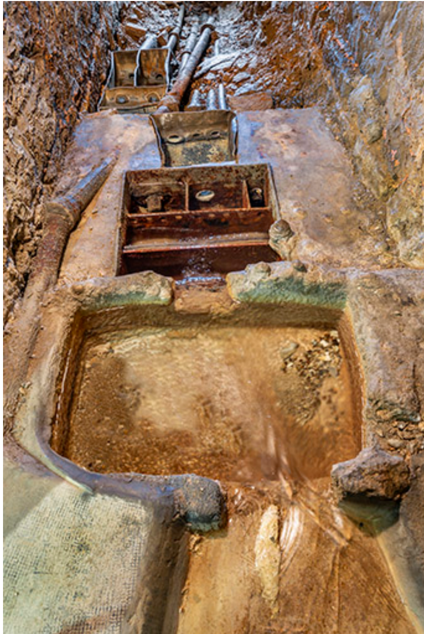
Bassins de division. Vue depuis l'amont.
