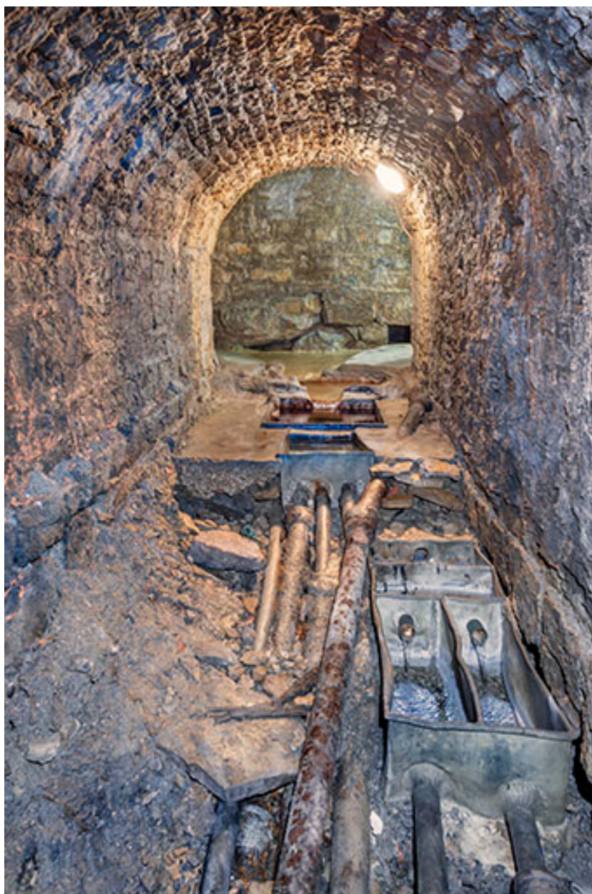
Galerie maçonnée renfermant les bassins de division. Vue depuis l'aval.
