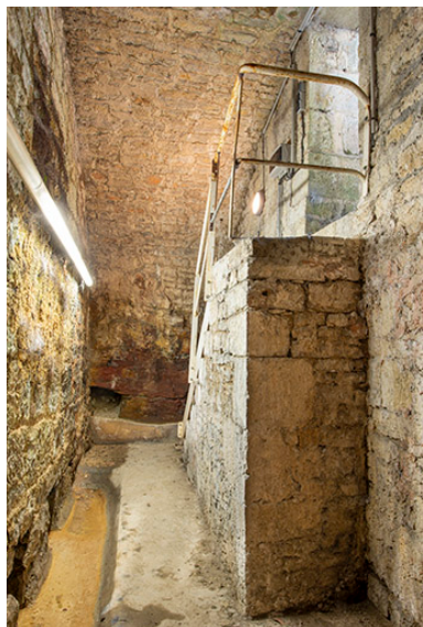
Pièce de captage des sources. Phot. Jérôme Mongreville IVR43_20233900649NUC4A
