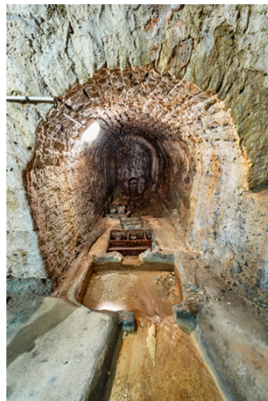
Galerie maçonnée renfermant les bassins de division. Vue depuis l'amont. Phot. Jérôme Mongreville IVR43_20233900643NUC4A
