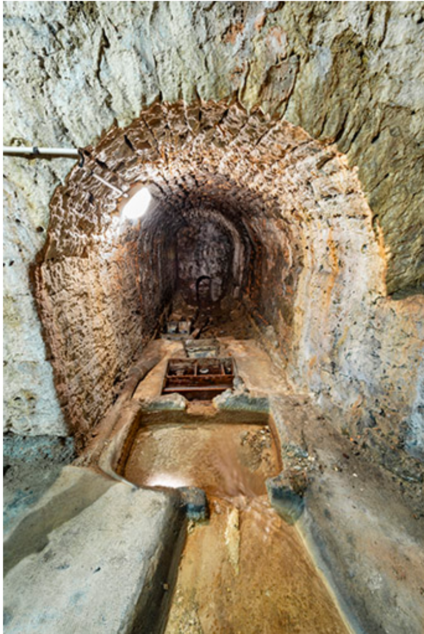
Galerie maçonnée renfermant les bassins de division. Vue depuis l'amont.
