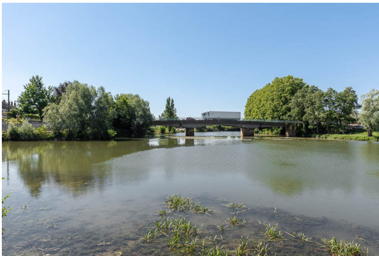
Vue générale du pont et du site.
