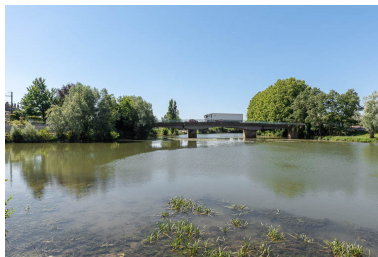
Vue générale du pont et du site. Phot. Pierre-Marie Barbe-Richaud IVR26_20187100281NUC4A
