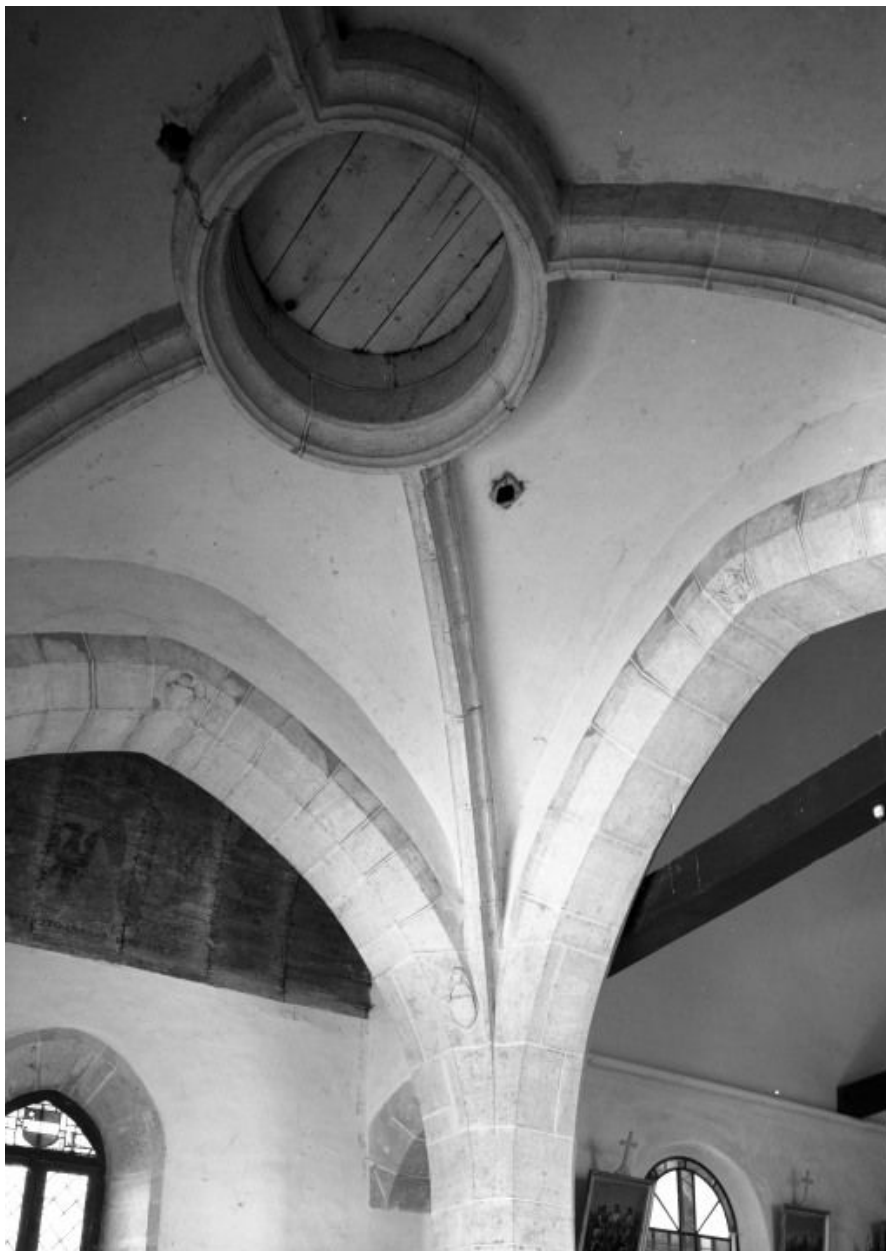
Voûte de la travée sous clocher
