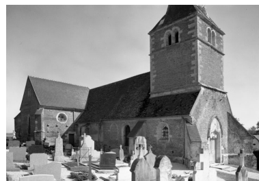
Elévations antérieure et gauche Phot. Michel Thierry IVR26_19852100470V
