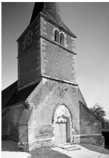
Elévation antérieure Phot. Michel Thierry IVR26_19852100471V
