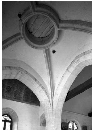
Voûte de la travée sous clocher Phot. Michel Thierry IVR26_19852100486V
