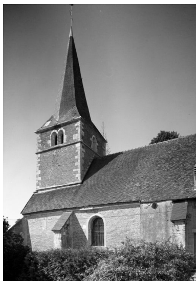
Clocher et élévation droite Phot. Michel Thierry IVR26_19852100475V
